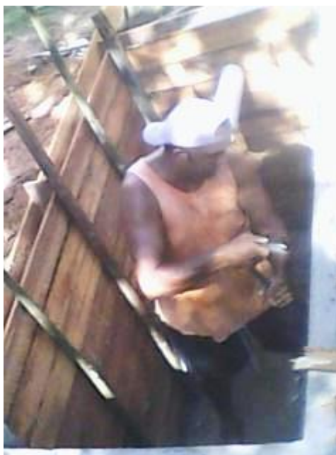
Figura 4.13 - Fotografia da construção do TS.
