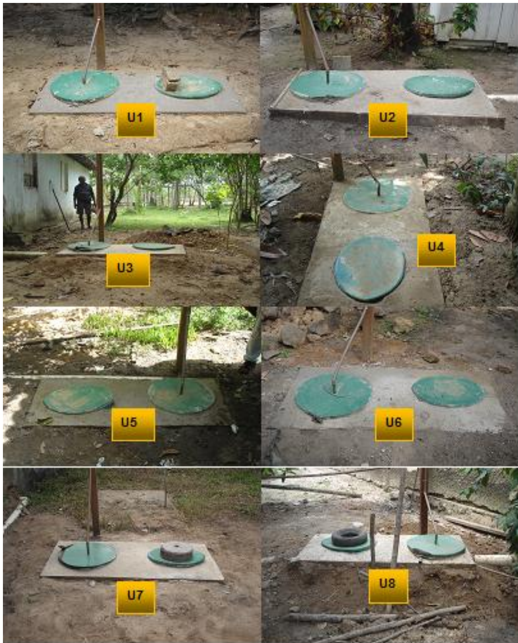
Figura 4.5 - Reactores UASB unifamiliar enterrados.
