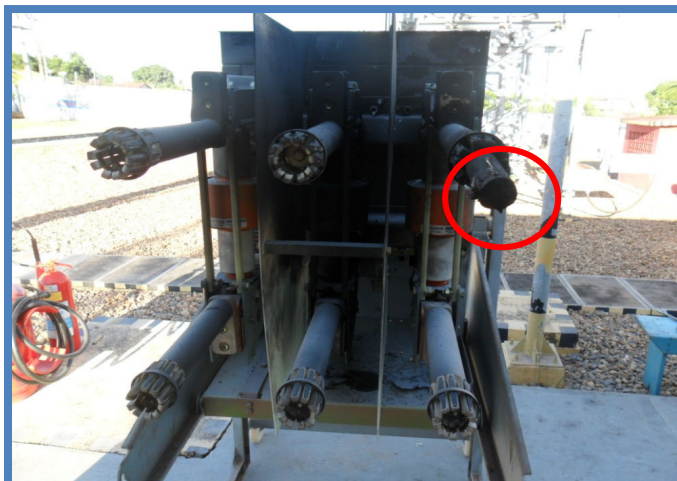
Foto 2 - Foto do disjuntor avariado.
