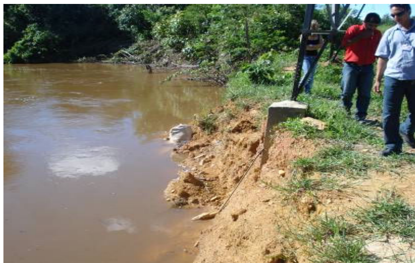
Foto 1 - Fundação da Torre comprometida.
