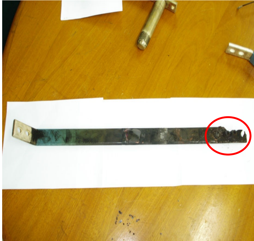
Foto 3 - Foto dos componentes internos do disjuntor avariado.
