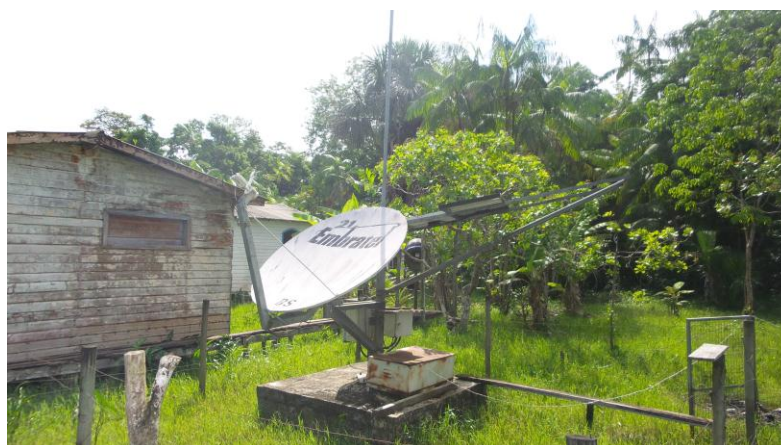
Figura 21 - Antena para captação do sinal para o telefone público (ao fundo)
