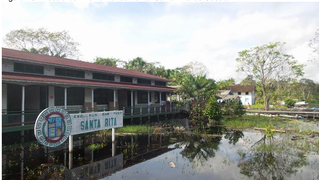
Figura 18 - Escola de Ensino Fundamental Santa Rita de Cássia
