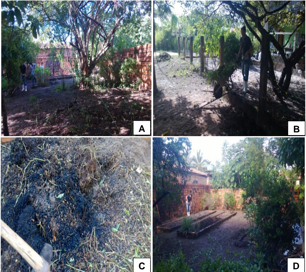
Figura 13: A- Limpeza da área por capina manual; B- Retirada de plantas daninhas; C- Revolvimento do solo e D- Nivelamento dos canteiros. Fonte: Pesquisa de campo, 2013.
