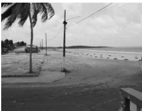
Figura 17 - Situação da praia antes da intervenção - chegada da PA-318 em Marudá, novembro de 2003
