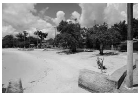
Figura 35 - Lado leste com Menor influência de ondas: depósito de sedimentos à base do muro devido à ação eólica, na Praia do Amor, Outeiro (PA), maio de 2009
