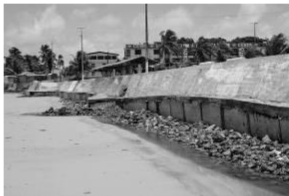
Figura 26 - Tentativa de contenção do solapamento da base do muro com pedras, em Marudá, maio de 2009
