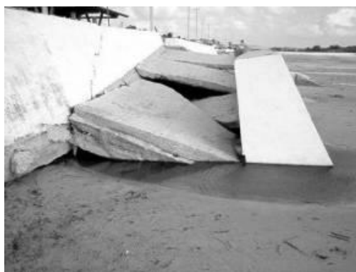
Figura 28 - Rampa 1 destruída - acúmulo de água denunciando o solapamento em sua base, em Marudá, julho de 2004
