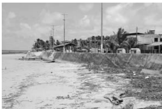
Figura 23 - Rampa 1 apresentando solapamento e acentuado desnível próximo a sua base, em Marudá, maio de 2009
