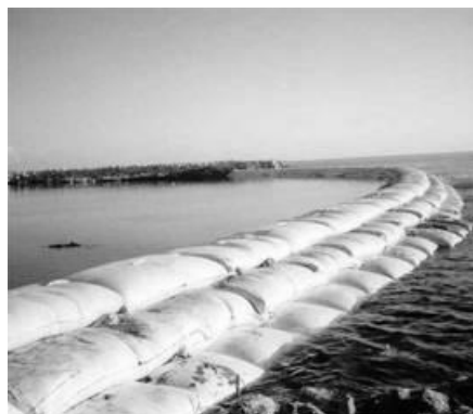
Figura 11 - Contenção em sacos de solo-cimento
