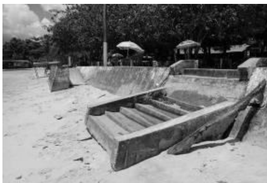
Figura 32 - Uma das escadas desmoronadas na Praia do Amor, Outeiro (PA), maio de 2009
