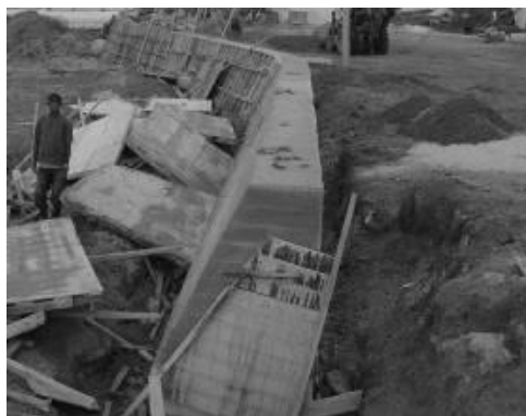
Figura 6 - Muro de concreto ciclópico, Marudá (PA) em julho de 2004
