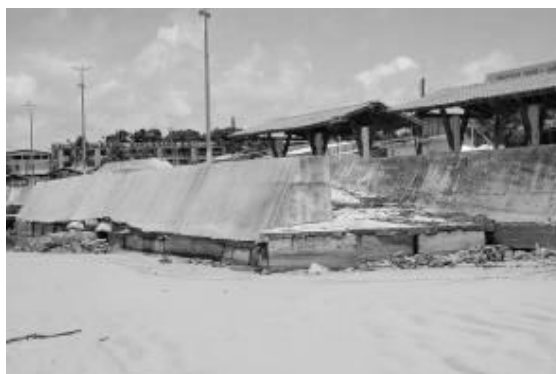
Figura 25 - Base da Rampa 1 apresentando solapamento em sua base com suas fundações aparentes - aparecimento de vãos na estrutura, em Marudá, maio de 2009
