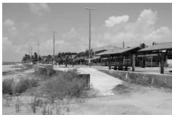
Figura 24 - Deposição de sedimentos à base da Rampa 2 devido à ação eólica, em Marudá, maio de 2009
