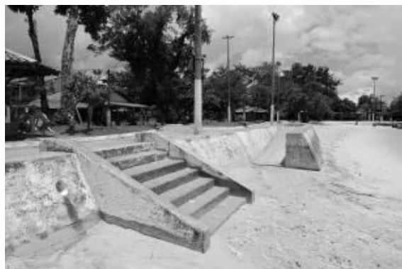
Figura 30 - Sistema de escadas e rampas de acesso à praia, na Praia do Amor, Outeiro (PA), maio de 2009
