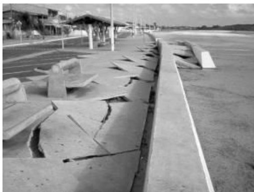
Figura 27 - Calçada afetada pelo colapso do paramento, em Marudá, julho de 2004
