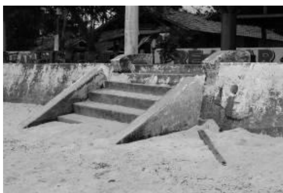
Figura 33 - Escada desmoronada na Praia do Amor, Outeiro (PA), maio de 2009
