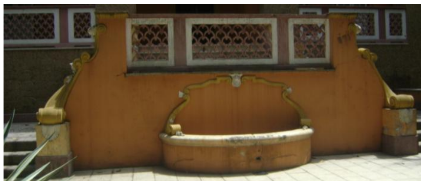
Figuras 42 e 43: Detalhes da pintura próxima a fonte e do tratamento feito com base de cimento para imitar pedra no Prédio do CIG, respectivamente.
