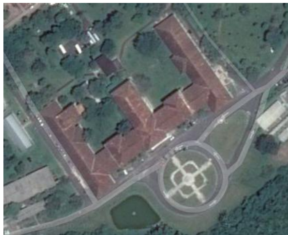
Figura 16: Forma de implantação do prédio central da Universidade Federal Rural da Amazônia, antigo Instituto Agrônômico do Norte.
