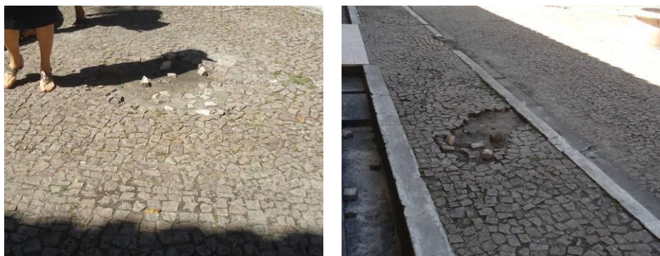
Figuras 222 e 223: Pavimentação em pedra portuguesa deteriorada, localizada na parte de externa do IECG.
