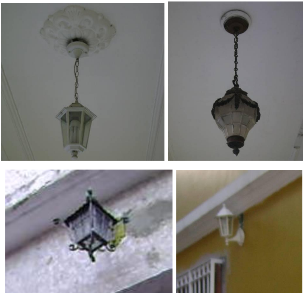
Figuras 375, 376, 377 e 378: Luminárias encontradas nas varandas do andar térreo e superior e as arandelas localizadas na fachada frontal e lateral esquerda da edificação, respectivamente.
