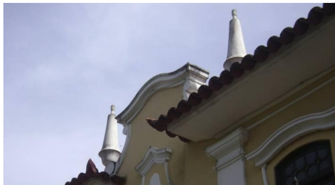
Figura 155: Detalhe da platibanda da fachada principal do prédio central do Instituto Estadual Carlos Gomes.
