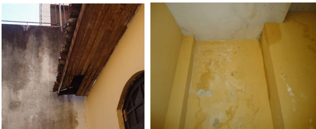
Figuras 227 e 228: Forro em madeira danificado do anexo 2 e área de infiltração entre o anexo 1 e o prédio central, respectivamente.
