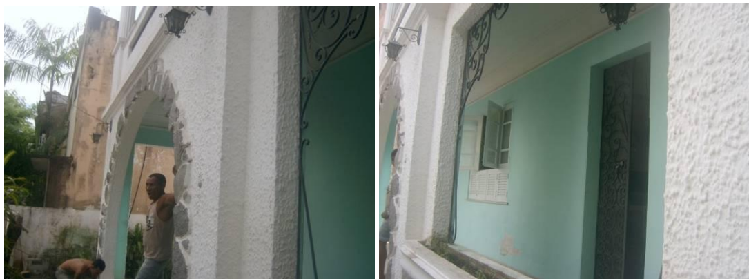
Figuras 319 e 320: Detalhes da parede externa com textura, das arandelas próximas ao arco e da cor da parede ao fundo, localizadas na fachada principal, respectivamente.
