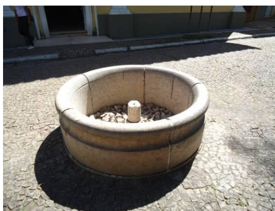
Figura 224: Chafariz danificado, necessitando restauração, localizada na parte de externa do IECG.
