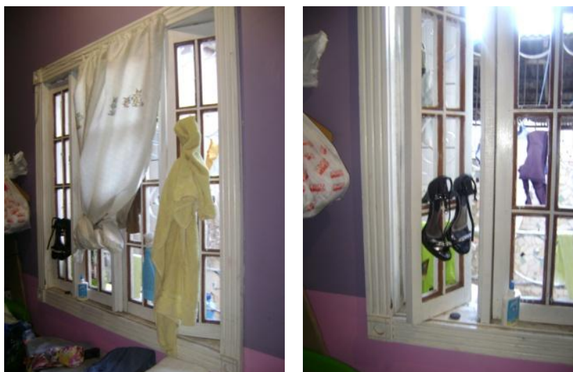
Figuras 364 e 365: Detalhes da janela do tipo pivotante encontrada em um dos cômodos.
