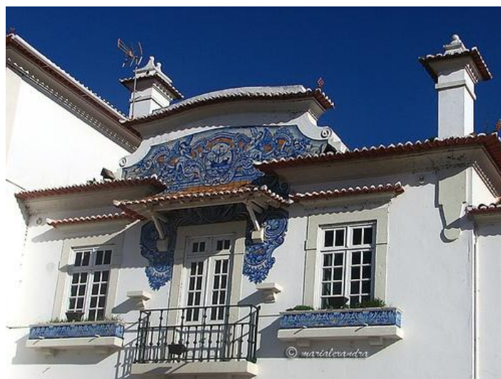
Figura 156: Detalhe da platibanda do antigo prédio da Estação Ferroviária de Aveiro em Portugal.
