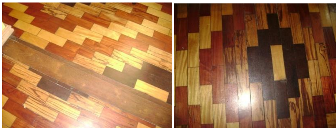
Figuras 379, 380 e 381: Detalhe do piso das salas de visitas e do corredor, no 1º pavimento.
