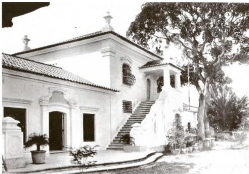
Figura 14: Fachada posterior do Solar Monjope.
