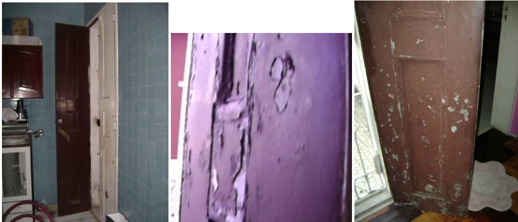
Figuras 410, 411, 412, 413 e 414: Detalhes das portas da copa, cozinha, pátio superior e dos quartos, respectivamente.
