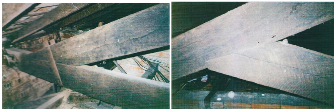
Figuras 220 e 221: Perna de tesoura trincada e ligação da asna e pernada de tesoura sem reforço metálico.
