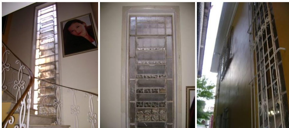
Figuras 361, 362 e 363: Detalhes do balancim próximo à escada, assim como da grade de proteção.
