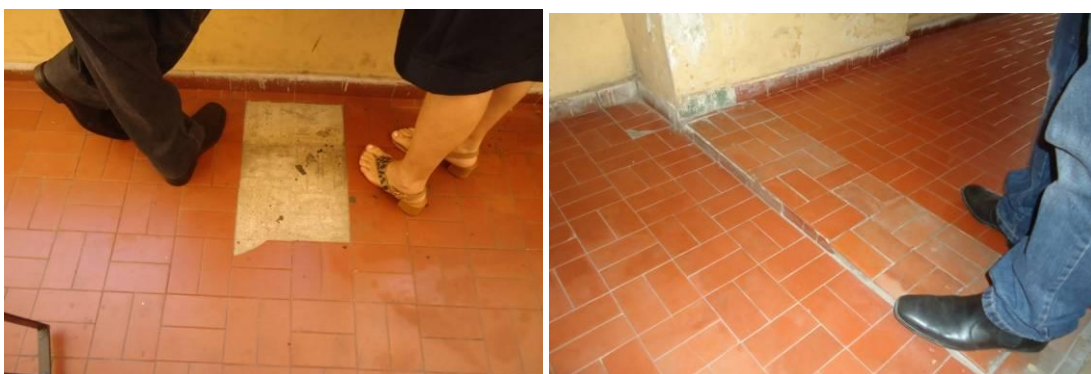
Figuras 225 e 226: Piso com lajotas quebradas e piso com presença de desnível não sinalizado, respectivamente.
