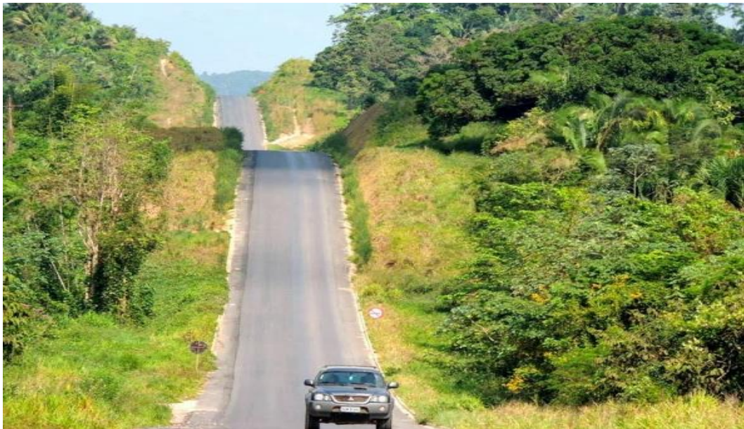
Imagem 16. Trecho da rodovia transamazônica asfaltada
