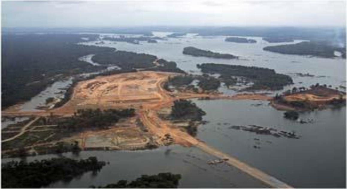
Imagem 15. Vista aérea da área onde está sendo construída a hidrelétrica de Belo Monte.
