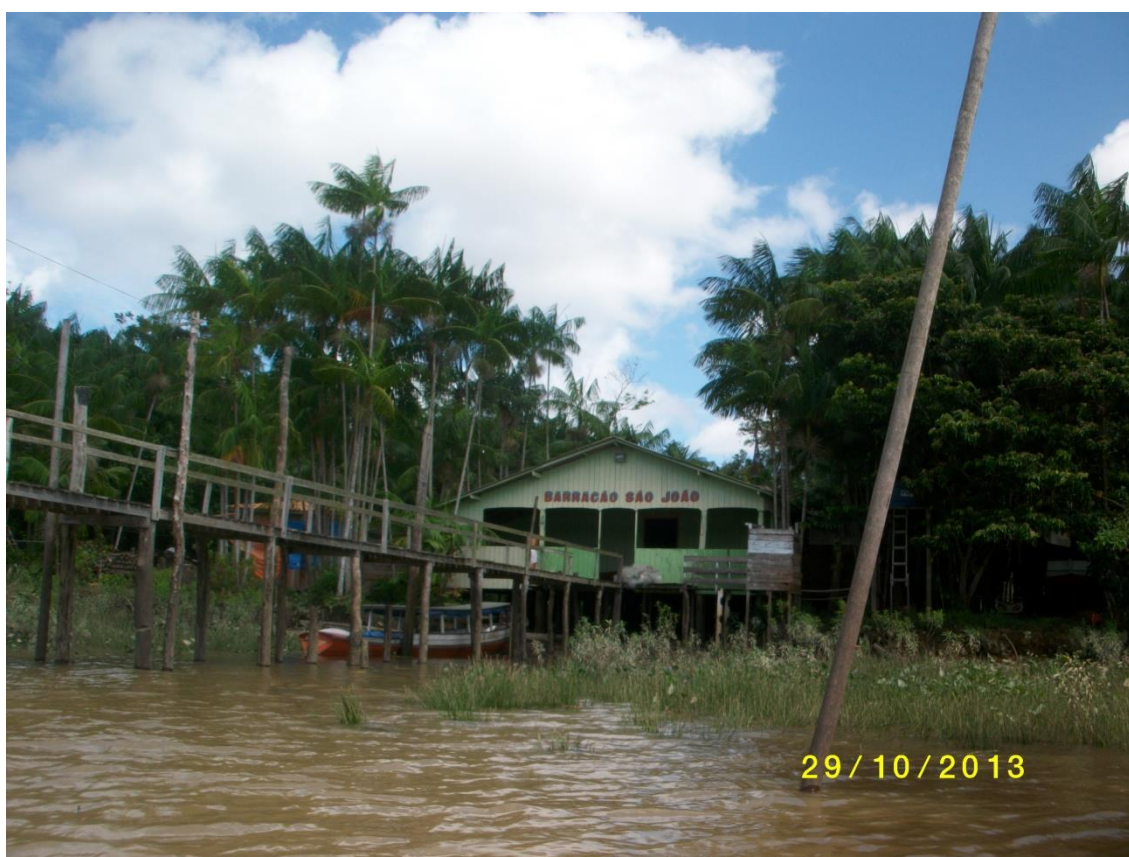
FIGURA 05: Sede da ASPANLI
