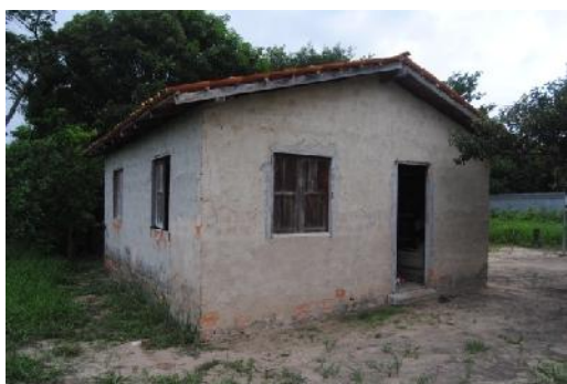
Figura 4- moradia com problemas na construção
