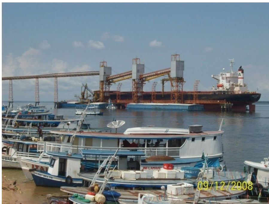
Figura 1 – Porto da CARGILL. Foto: Otávio do Canto, 2008.
