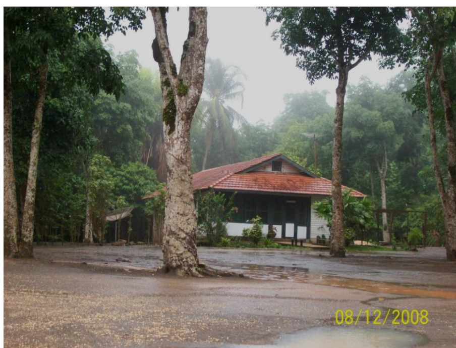
Figura 8 – Construção da época do projeto Ford. Foto: Andréa Coelho, 2008.
