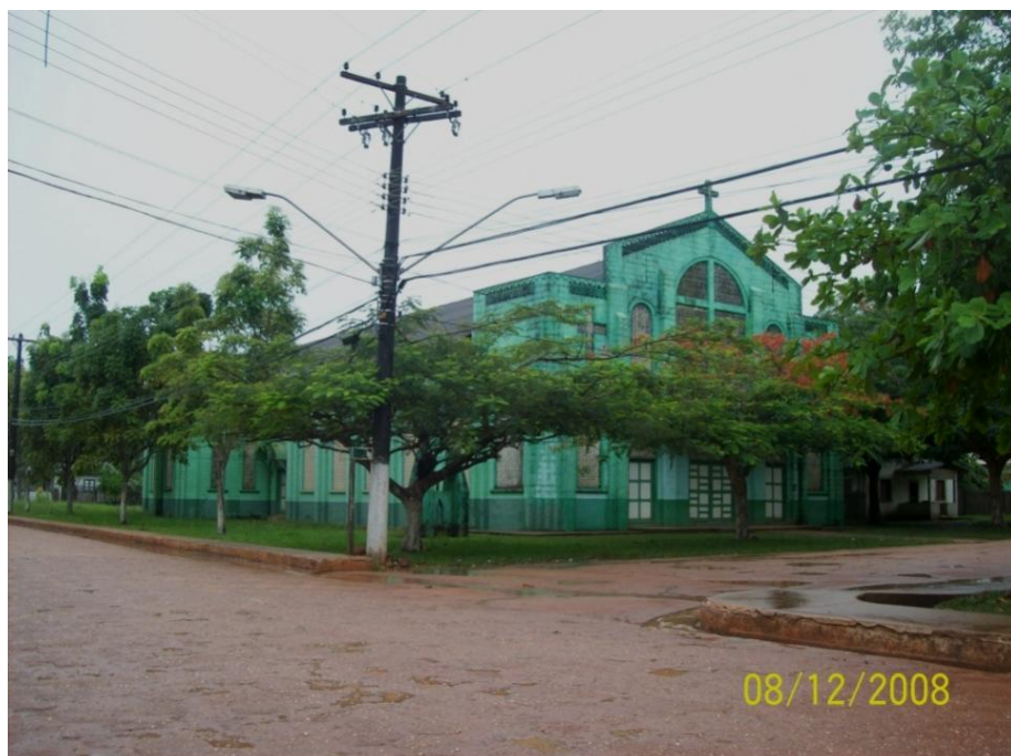
Figura 7 – Construção da época do projeto Ford. Foto: Andréa Coelho, 2008.
