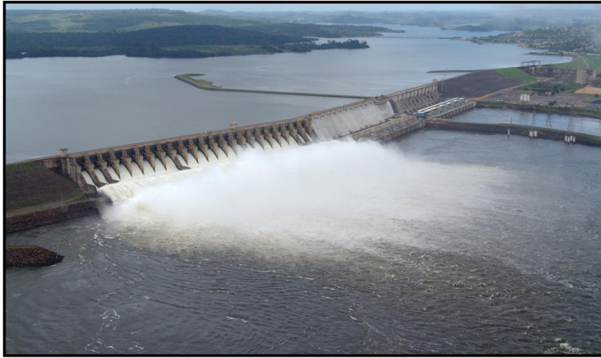
Figura 28- Usina Hidrelétrica de Tucuruí Barragem no Tocantins.
