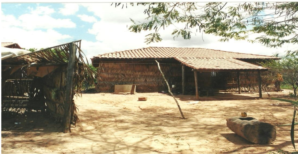
Figura 05 – paredes de palha com cobertura de telha de barro (Edmar guarani). 2007.
