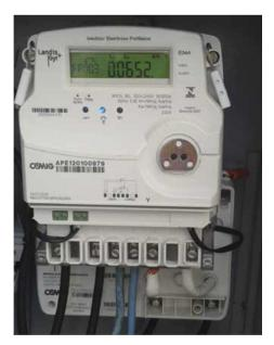
Figura 2.8 – Medidor inteligente da Cemig. Fonte: Revista O Setor Elétrico<sup>1</sup>.
