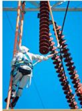
Figura 1.2 – Inspeção de patrulhamento (CTEEP, 2008).
