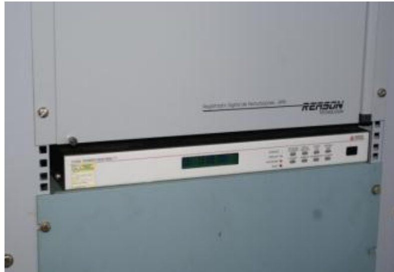
Figura 2.11 – Equipamento para coleta de dados elétricos. Analisador de Energia instalados nas SE.
