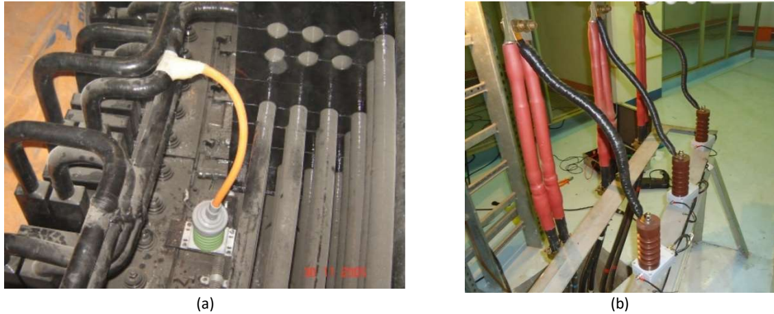
Figura 3.9 – Acopladores capacitivos: a) Instalado no interior do enrolamento; b) Instalado na saída de fase. Fonte: Próprio autor.
