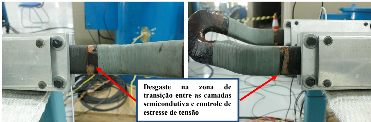
Figura 6.65 – Desgaste na zona de transição entre as camadas semicondutora e de estresse de tensão.
