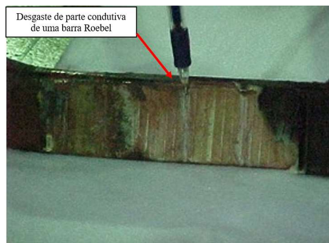
Figura 3.7 – Desgaste da parte condutiva de uma barra Roebel.
