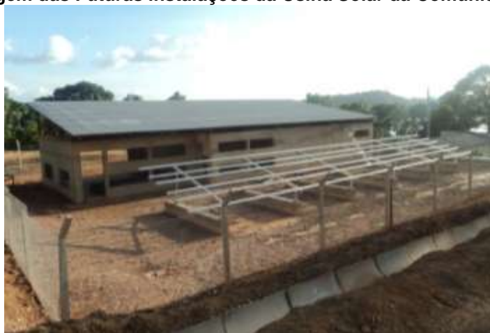
Figura 22 – Imagem das Futuras instalações da Usina Solar da Comunidade Vila Padaria
