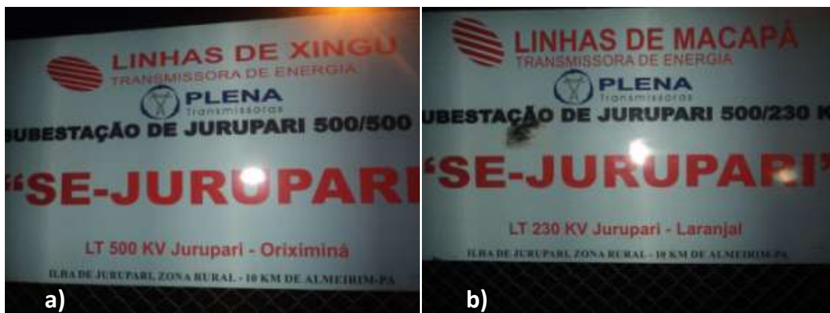
Figura 27 – Linhas de Transmissão. a) LT Oriximiná – Jurupari (PA). Tensão 500 kV; b) LT Jurupari – Laranjal. Tensão 230 kV.
