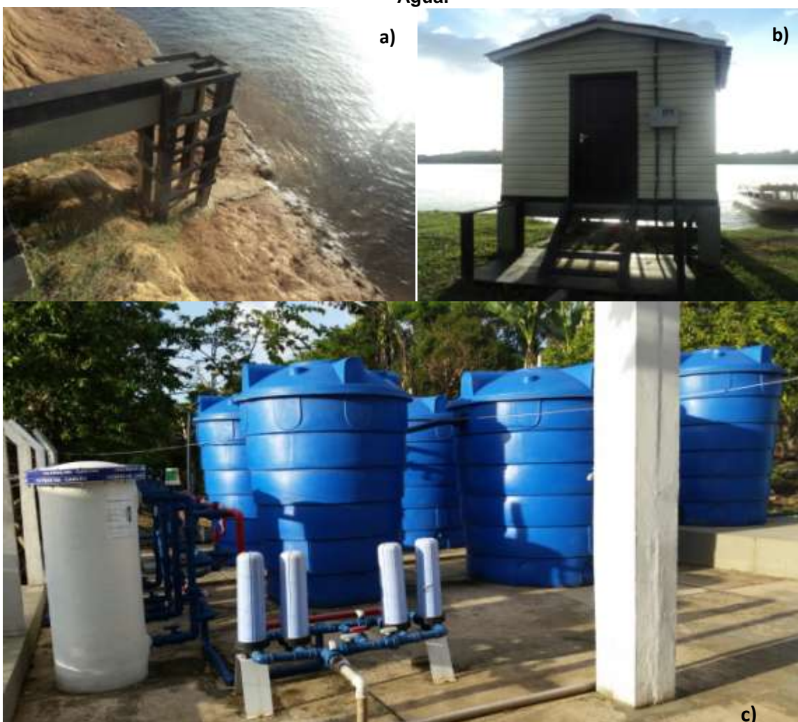
Figura 21 – Tratamento de Água na Comunidade Vila da Padaria. a) Captação da Água do Rio Jari; b) Casa de Bombeamento para a Estação de Tratamento; c) Estação de Tratamento de Água.
