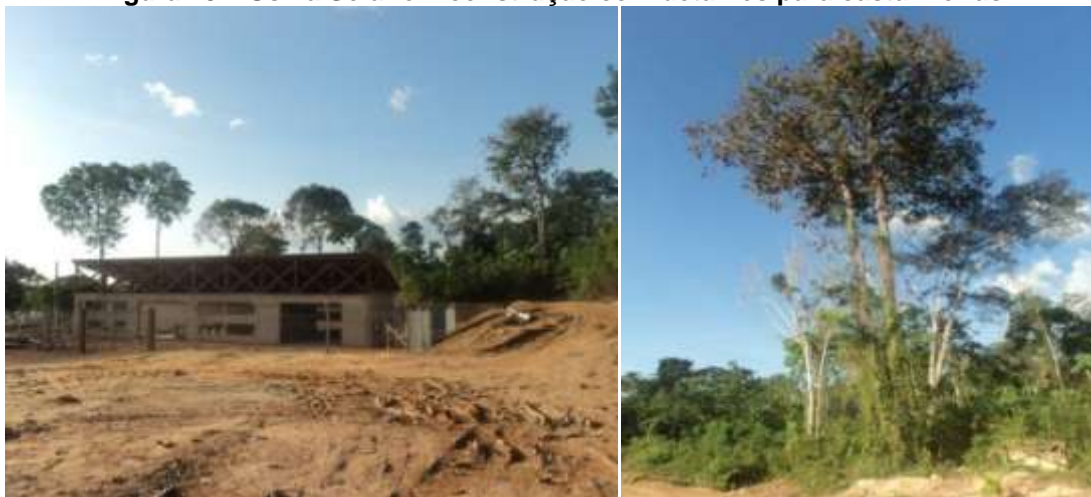
Figura 23 – Usina Solar em construção com detalhes para castanheiras
