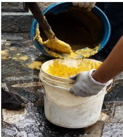
**Figura 4.3:** Material Residual Gorduroso sendo transferido para recipientes de 20 litros.
