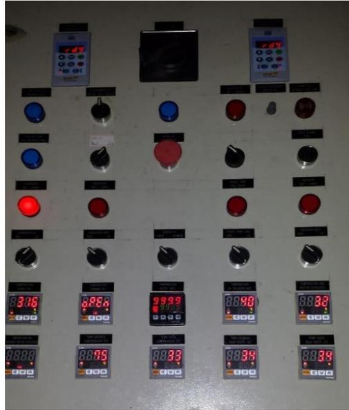
**Figura 4.35:** Painel do Sistema de Controle da Unidade Piloto de Craqueamento.
