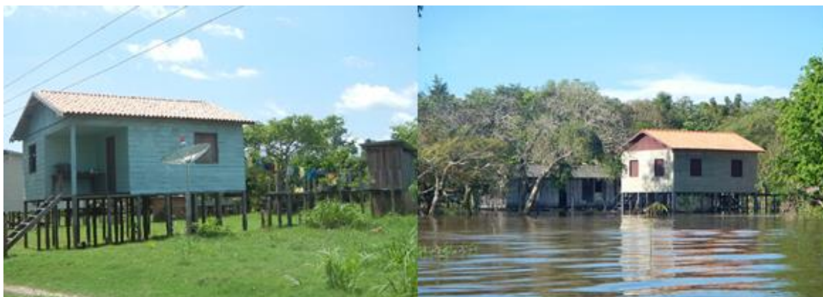
Fotografia 5 - Casas construídas pelo Programa do Crédito Habitacional de INCRA no PAE, Aritapera, no município de Santarém
