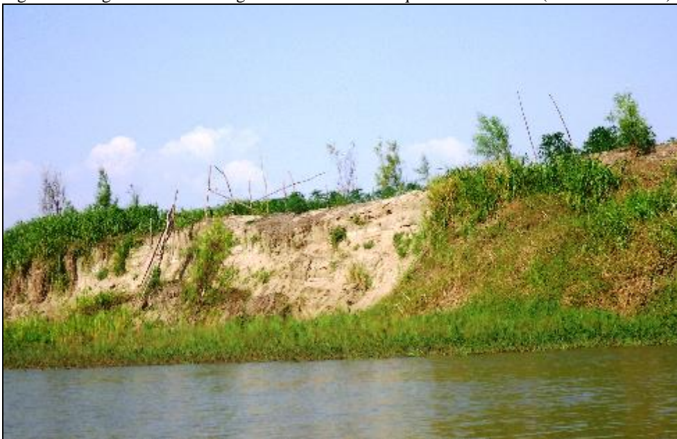
Figura 4. Imagem de local na Água Preta onde houve queda de barranco (Dezembro/2014).
