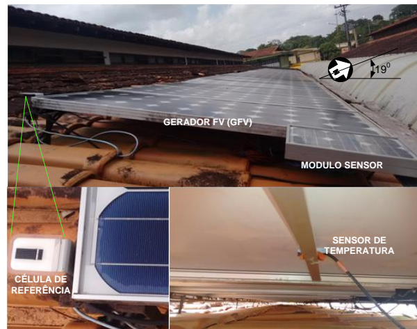
Figura 3.25 – Célula calibrada e módulo sensor, ambos instalados no mesmo plano do gerador FV.
