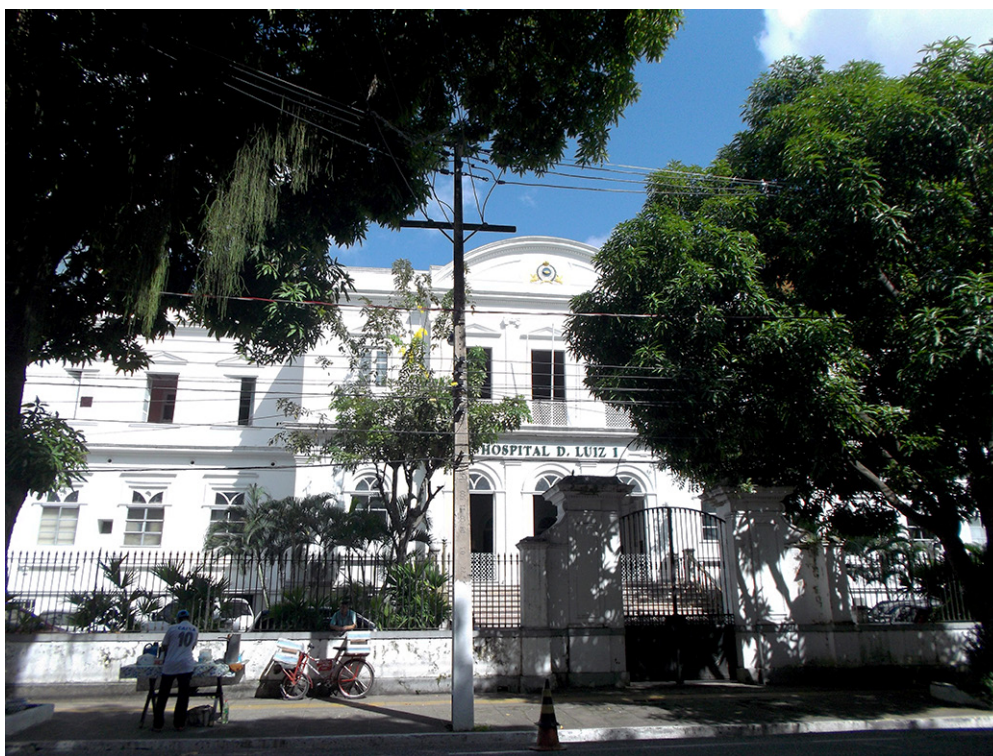
Figura 2 – Fachada principal do Hospital Dom Luiz I, com destaque para seu corpo central. Fotografia de Cybelle Miranda, 2016.
