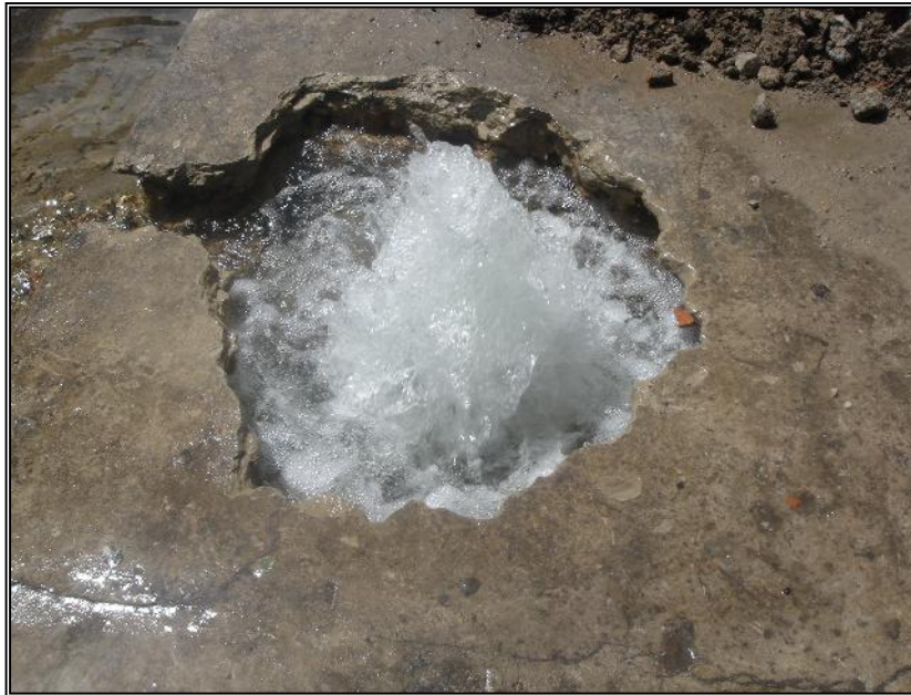
Fotografia 3 - Vazamento visível na rede de distribuição de água do 3º setor
