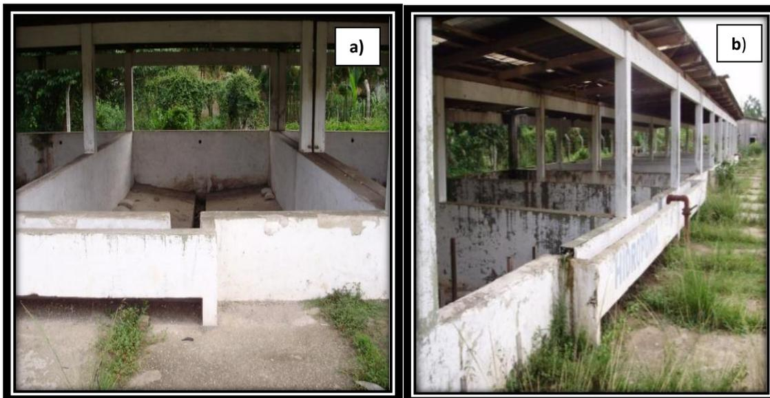
Figura 32: Apresenta detalhes do Leito de secagem da ETE Sideral: a) Unidades de secagem do lodo da ETE; b) leito de secagem
