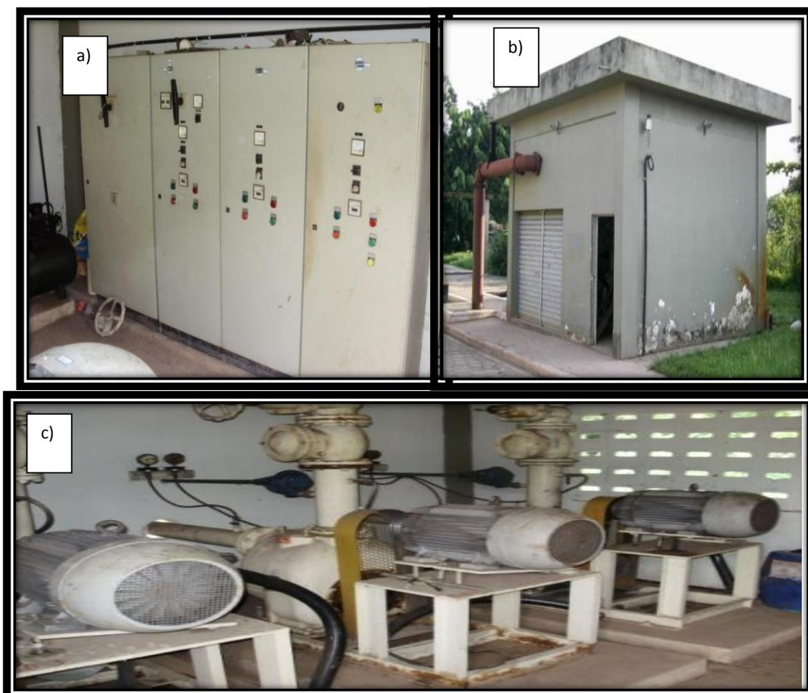
Figura 29: Apresenta em detalhes a estação elevatória: a) casa de bombas, b) quadro de comando elétrico e c) conjuntos motor bombas.
