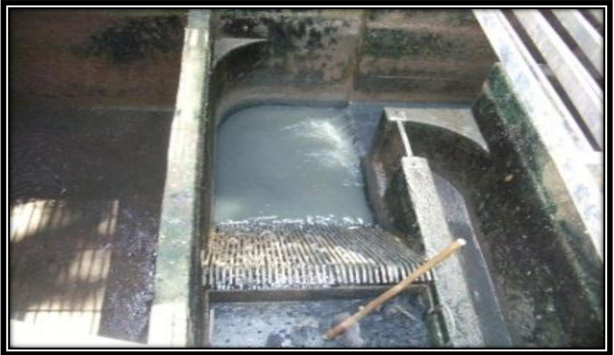
**Figura 24:** A chegada do esgoto bruto no sistema de Gradeamento da ETE Sideral
