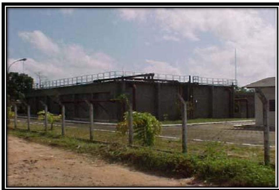
**Figura 7: Demonstra o reator UASB com suas 04 células
