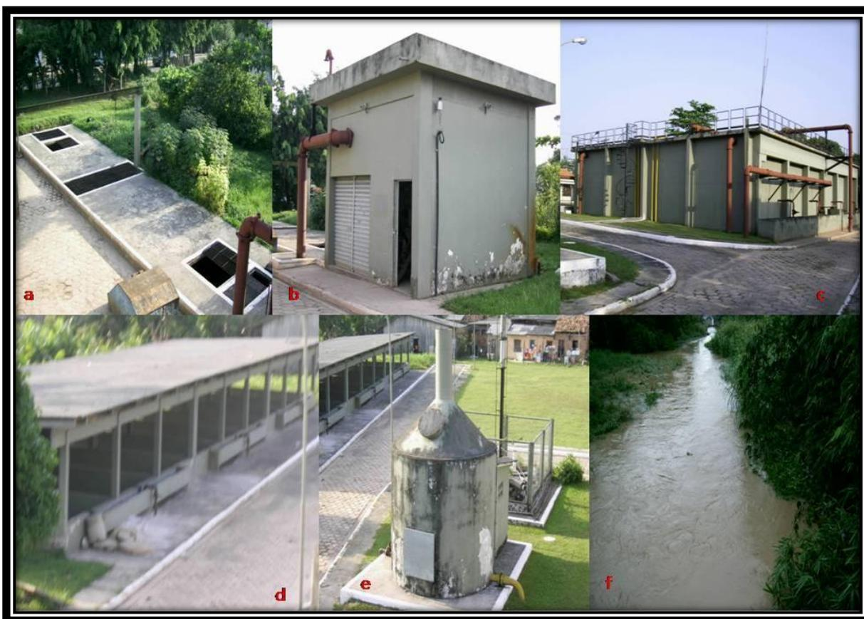
Figura 23: Demonstra as partes componentes do sistema de tratamento de Esgoto do Sideral, (a) grade e desarenador, (b) elevatória, (c) reator UASB, (d) Leito de secagem, (e) tratamento de gases e (f) Canal Massaquara.
