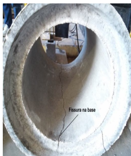
Figura 4.2 – Fissura na base
