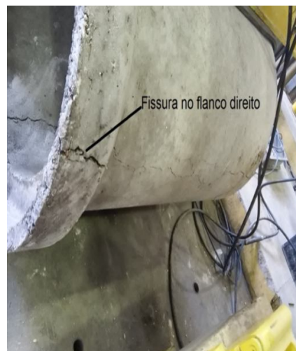
Figura 4.4 - Fissura no flanco direito
