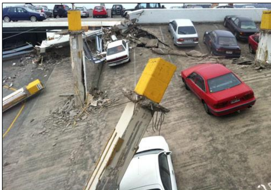
Figura 1. 1 - Ruptura por punção em garagem comercial, utilizando lajes lisas, Christchurch, Nova Zelândia.
