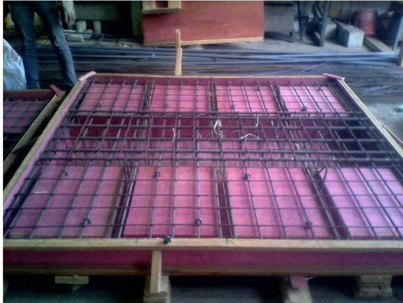
**Figura 20** – Forma utilizada para fabricação das lajes
