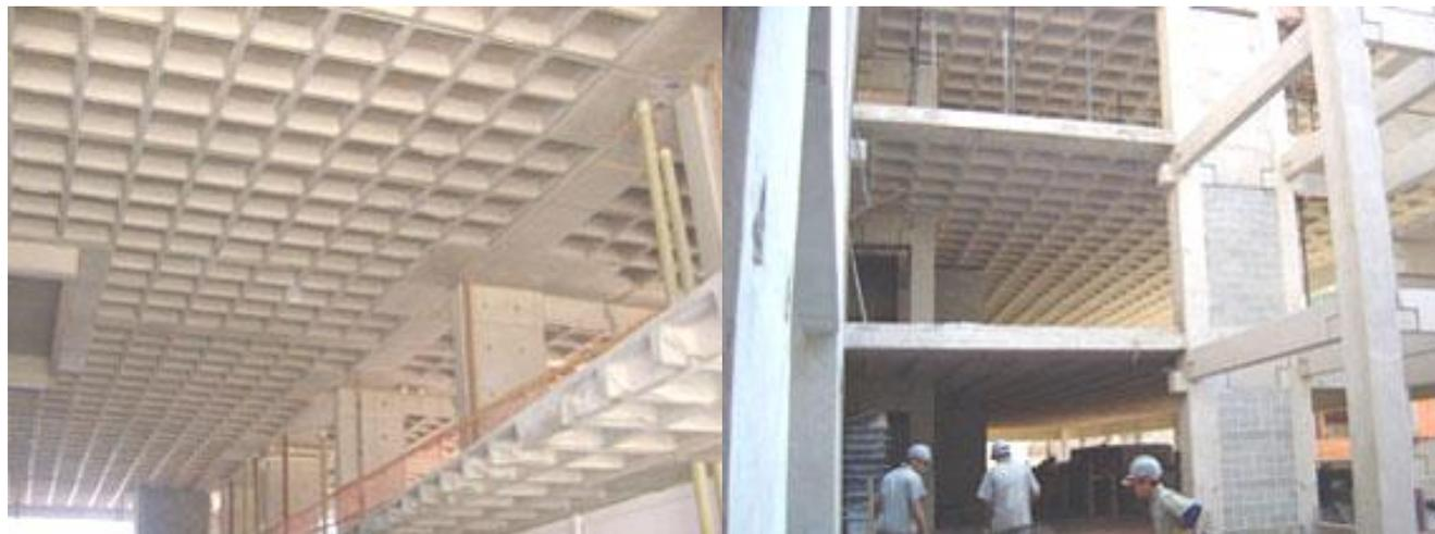
**Figura 2** – Edificações executadas com lajes nervuradas (Fonte: ATEX Brasil)
