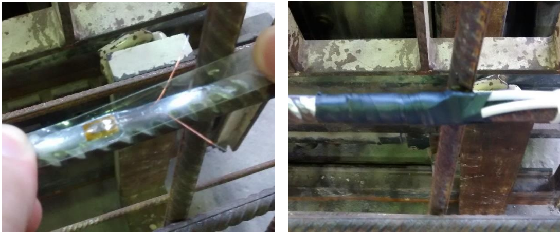
Figura 4.27 – Fixação dos extensômetros nas barras
