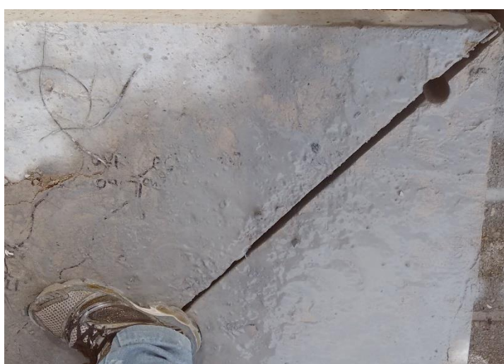
Figura 5.27 – Laje após o corte da superfície superior
