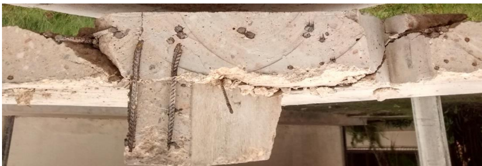
Figura 5.33 – Superfície e inclinação do cone de ruptura da laje L3
