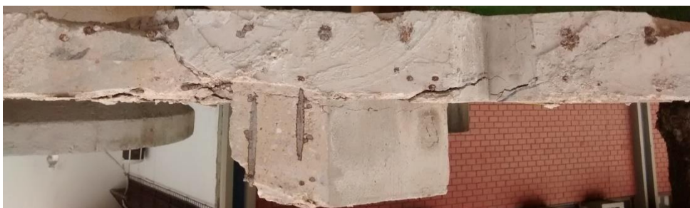
Figura 5.32 – Superfície e inclinação do cone de ruptura da laje L2
