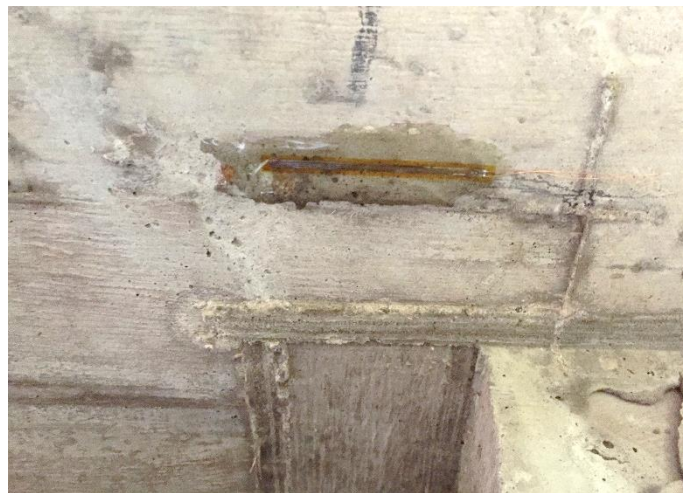
Figura 4.31 – Extensômetro do concreto
