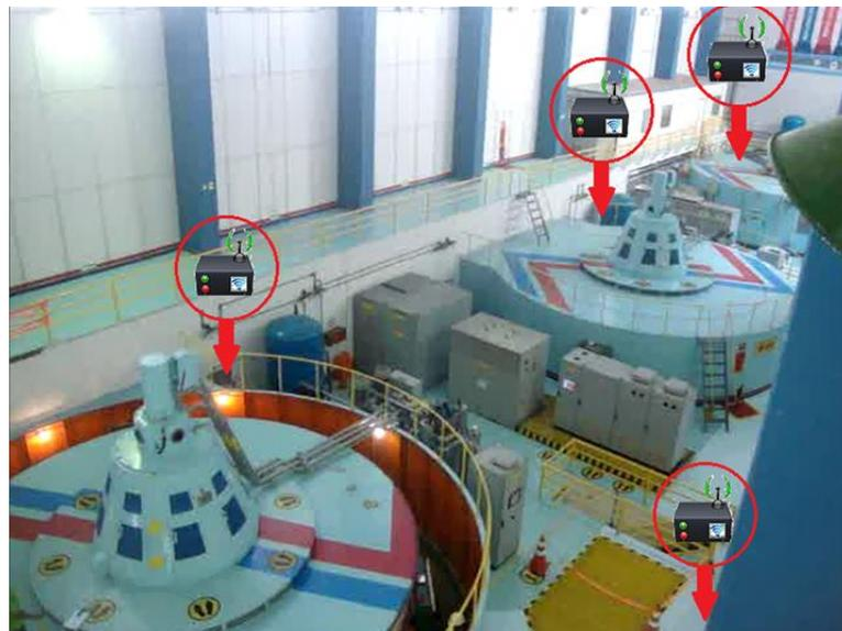
Todos os instrumentos e extensores de rede são alimentados a partir de um barramento CC de 250 V (circuito retificador e banco de baterias) dos serviços auxiliares da UHE de Coaracy Nunes. Como a tensão de 250 V CC é incompatível com a tensão de alimentação dos instrumentos e dos extensores, foram especificados dois conversores CC-CC do tipo *buck*
