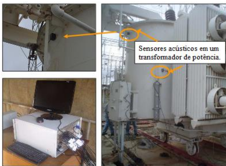
Figura 2.15 – Sensores acústicos instalados em um transformador de potência.
