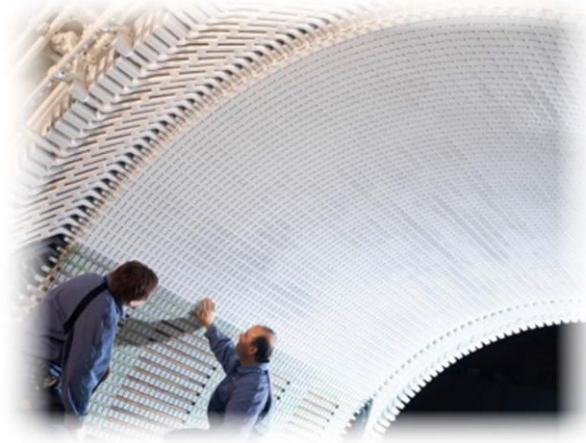
Figura 3.3 - Estator de hidrogerador.
