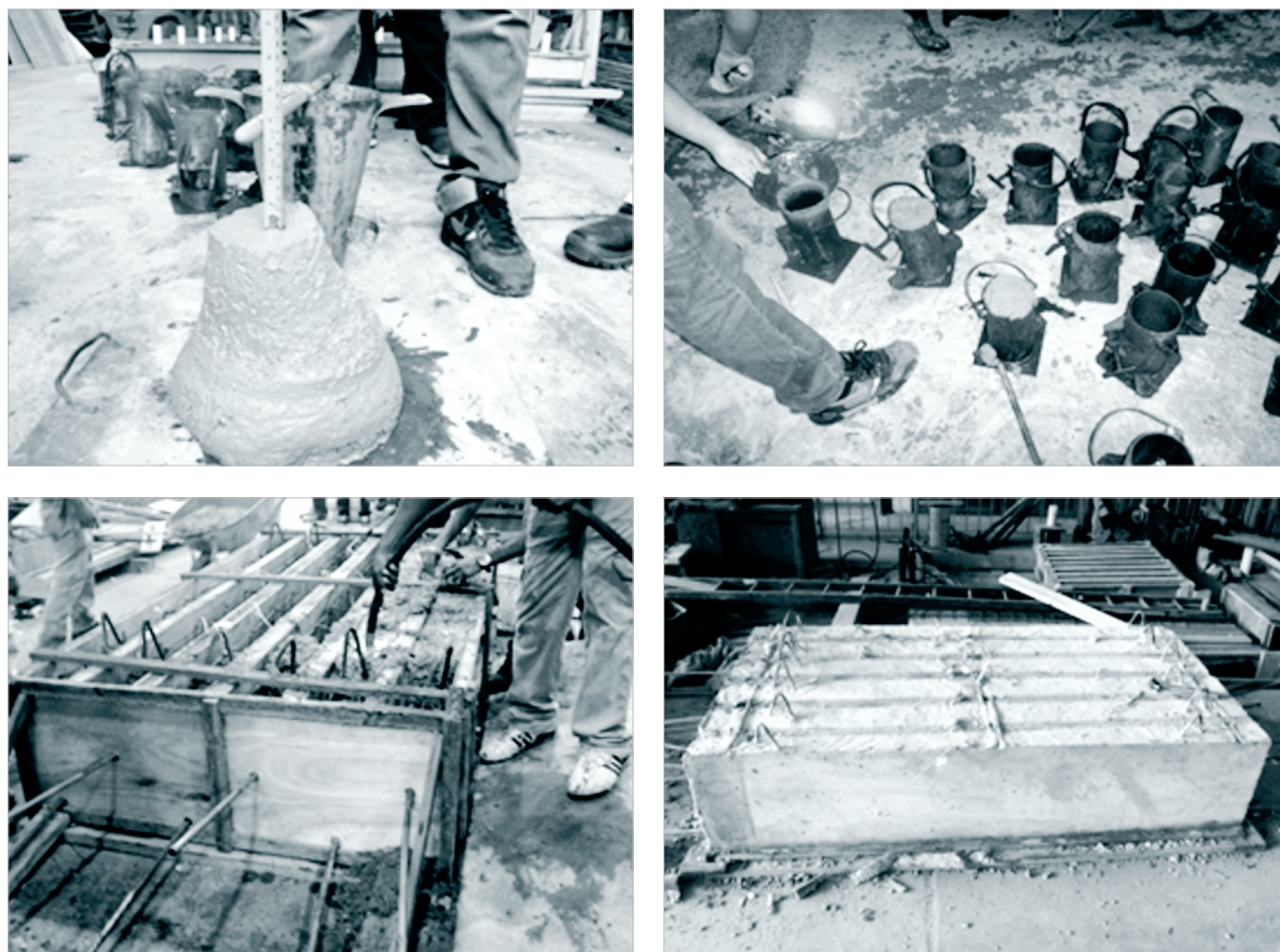
Figura 5 – Processo executivo das vigas
