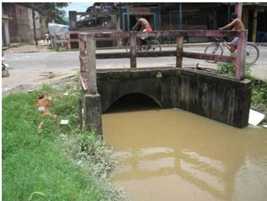
Foto 5: Bueiro Situado no Encontro dos Canais de Drenagem da Avenida Bernardo Sayão e Rua dos Timbiras. Às 13:30h do dia 21/03/2007.
