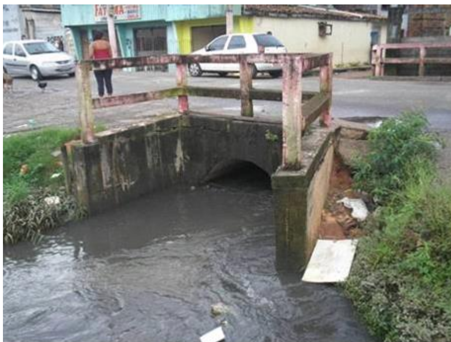
Foto 7: Bueiro Situado no Encontro dos Canais de Drenagem da Avenida Bernardo Sayão e Rua dos Timbiras às 17:00h do dia 21/03/2007.
