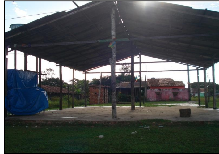
Figura 05 – Associação dos Moradores do Assentamento Jardim Rosália (trabalho de campo, 2012).
