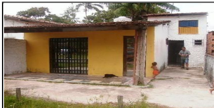
FOTO 08: RESIDÊNCIA NO BAIRRO CARANANDÚBA – Imóvel que possui um terreno medindo 7 m de frente por 40 m de fundo, com ponto comercial, sala, banheiro, quarto nos altos e quintal. Avaliado em $ 24.000,00 (vinte e quatro mil reais) (Foto: João Araújo, agos. 2012).
