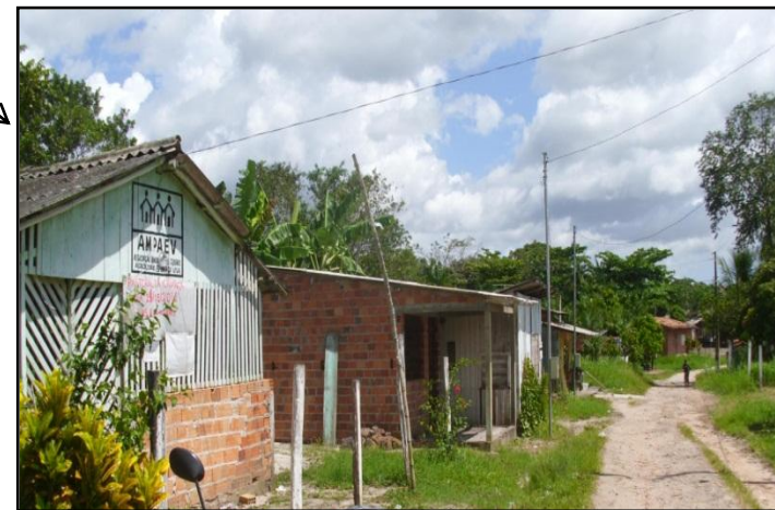
Figura 12 – Dorothy II: rua sem revestimento asfáltico e iluminação pública (trabalho de campo, 2012).
