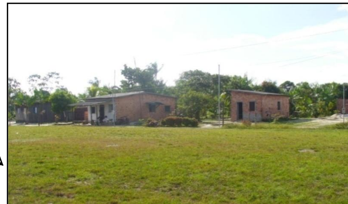
Foto 10 – Dorothy I: casas inacabadas, ruas sem asfalto e rede de esgoto (trabalho de campo, 2012).
