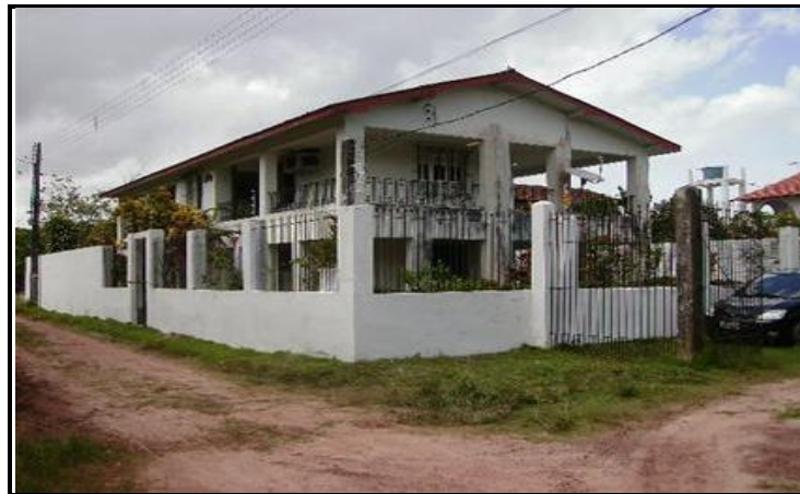
FOTO 07: RESIDÊNCIA SECUNDÁRIA – imóvel avaliado em $ 90.000,00 (noventa mil reais), com jardim, estacionamento, varandas, casa para caseiro, salas, quartos, cozinha, além de vista para a praia(Foto: João Araújo, jul. 2012).
