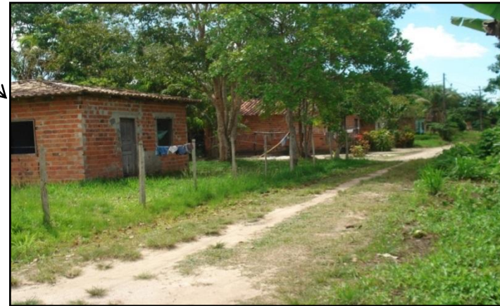
Figura 08 – Mártires de Abril: casas inacabadas, rua sem rede de esgoto e sem pavimentação (trabalho de campo, 2012).
