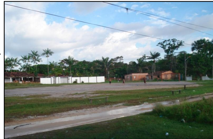
Figura 06 – Jardim Rosália: rua sem rede de esgoto e sem pavimentação (trabalho de campo, 2012).
