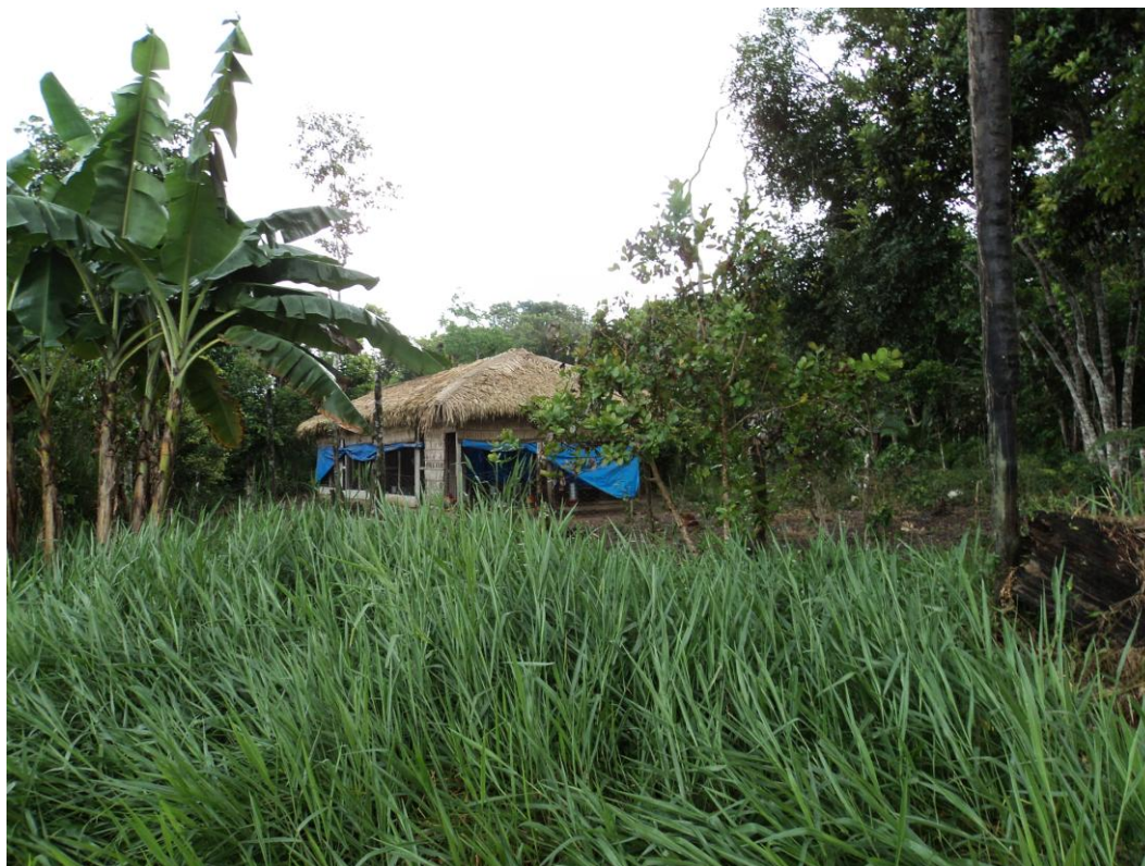
Foto 06: Aviário construído com o investimento do FUNBIO (Julho de 2011)
