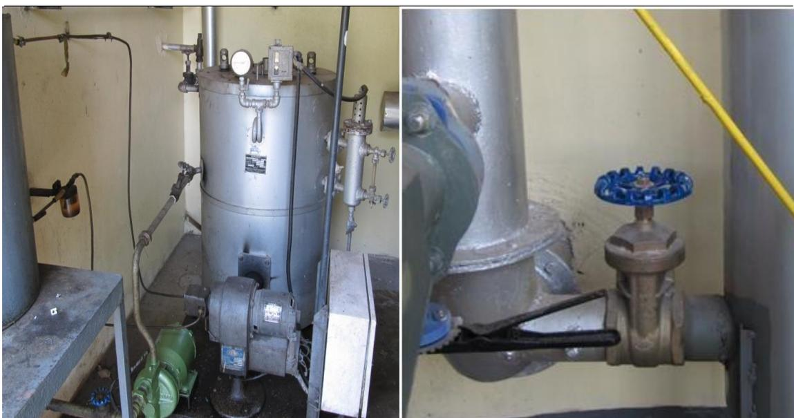
**Figura 3.7** – Caldeira já existente utilizada como fonte de geração de gás de combustão e ponto de captação dos gases na base da chaminé da caldeira.
