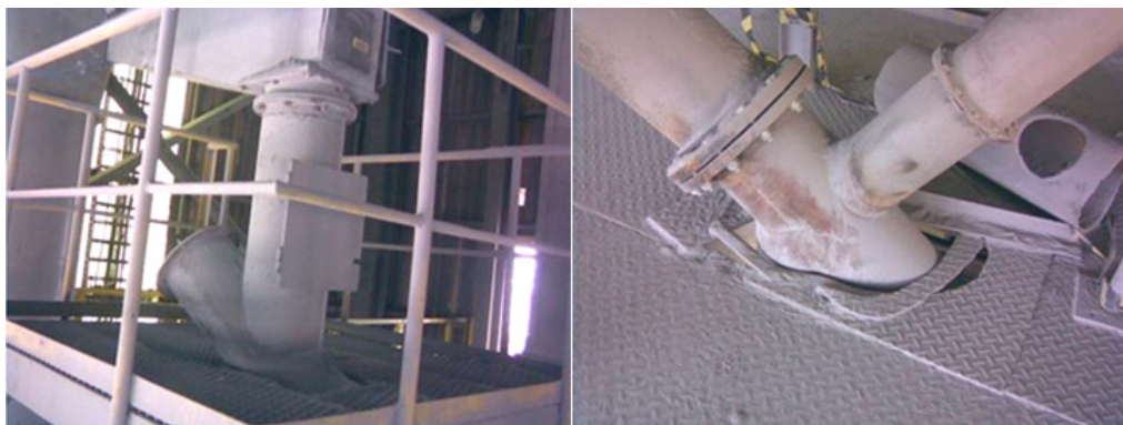
Figura 6.2 - Detalhes da descarga livre de pó de crosta (sem válvula rotativa) do FM 223001 antes da instalação do tubo fluidizado metálico descrito no capítulo 3 – fonte: Albras.
