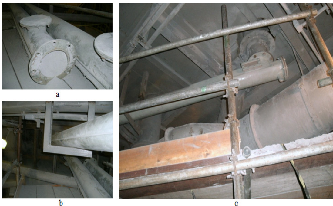
Figura 6.3 - a) Tubo fluidizado metálico de 8”/9 metros substituído após vazamento de pó entre a manta porosa e carcaça; b e c) tubo fluidizado concluído em fibra de vidro de vidro de 6” em fase de instalação, inclinado a 4° capacidade de transporte de até (184,24 t/h – 120 cm / min ) de pó de crosta coletada pelo FM 223001 da Albras.
