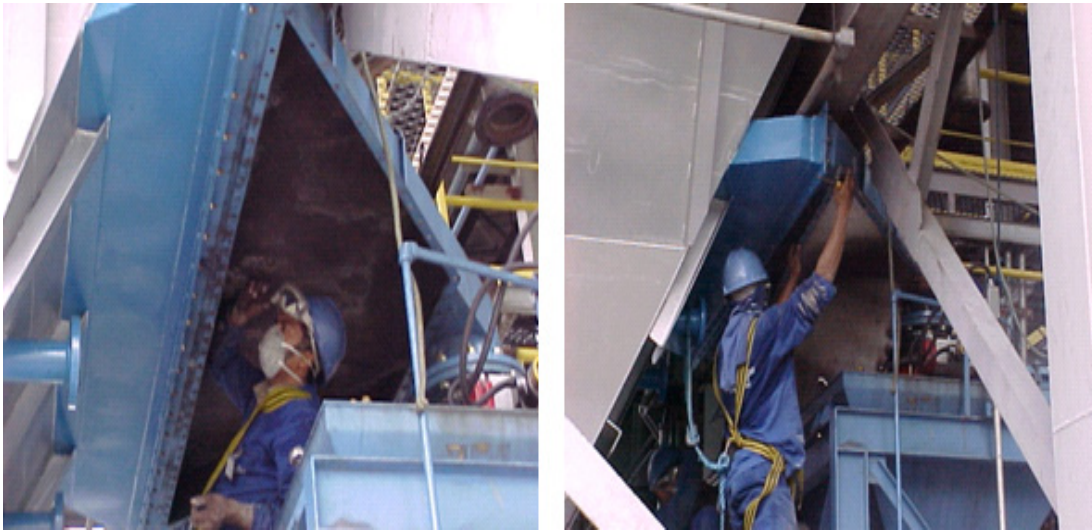
Figura 5.12 - Detalhes da montagem do chute de descarga do leito fluidizado na moega de abastecimento do transporte pneumático em fase densa da alumina reagida – fonte: Albras.
