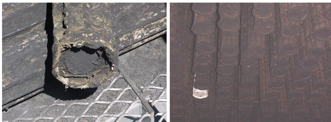
Figura 5.3 - Mangas filtrantes do FM 212002 entupidas pelo alcatrão da corrente gasosa do forno de cozimento anodos E da Albras.
