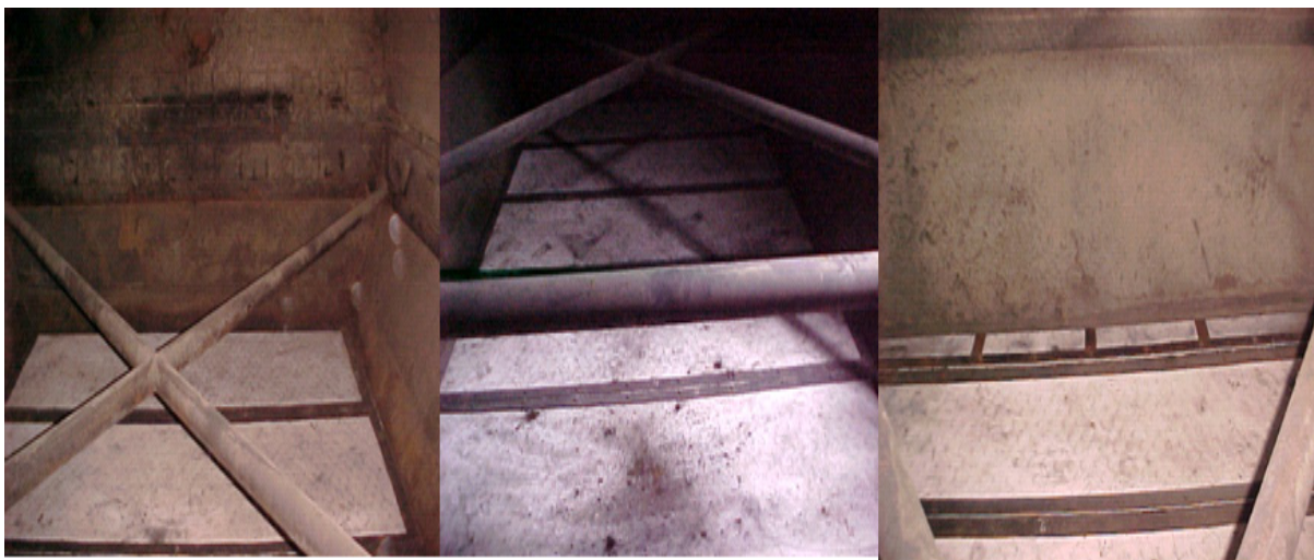
Figura 5.11 - Detalhes da montagem dos módulos do leito fluidizado na moega do FM212002 da Albras.
