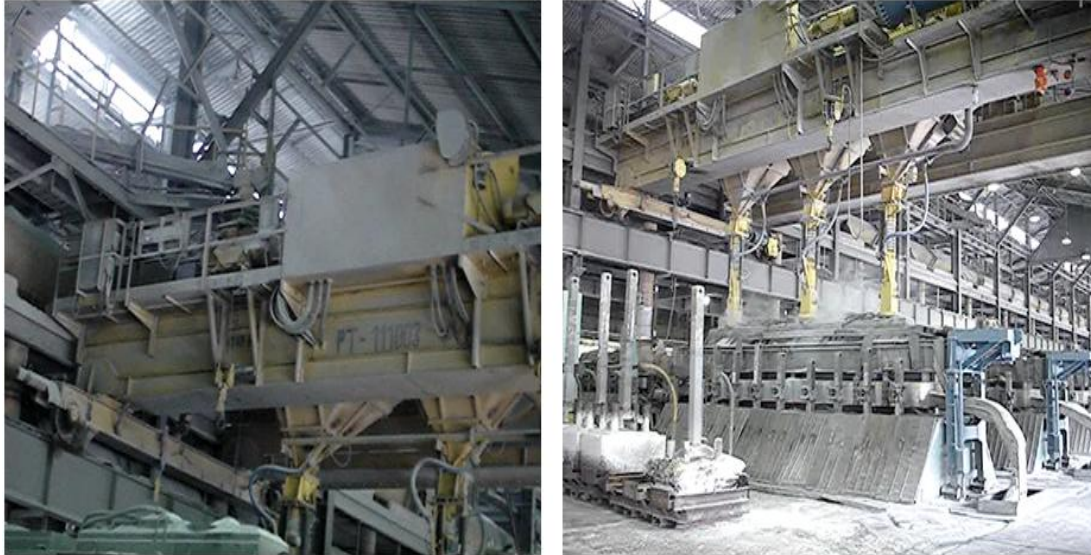
Figura 1.2 - Abastecimento de cubas eletrolíticas para produção de alumínio primário - fonte: Albras.
