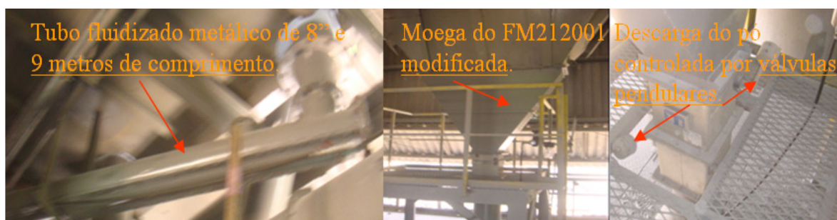
Figura 6.4 - Modificações feitas no FM 223001 para descarga do pó de crosta coletado neste filtro, e descarregada no processo da OCH através do tubo fluidizado metálico de 8”/9m – fonte: Albras.
