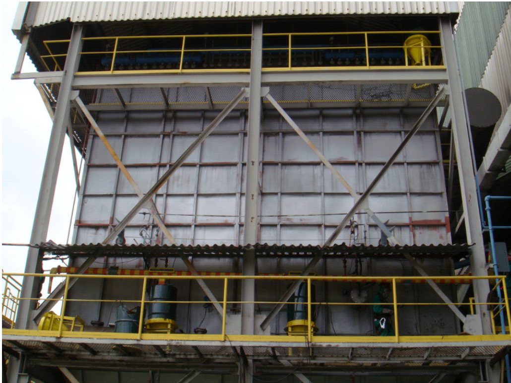
Figura 4.27 – Laboratório de fluidização para ensaio do transportador pneumático fluidizado (11) de 3” de diâmetro com 9,3 metros de comprimento – no detalhe o tambor de alimentação (13) na parte superior e os tambores (13) na plataforma intermediária simulando as moegas na cuba eletrolítica nas três descargas do transportador pneumático fluidizado (11) na parte intermediária do prédio – fonte: Albras.
