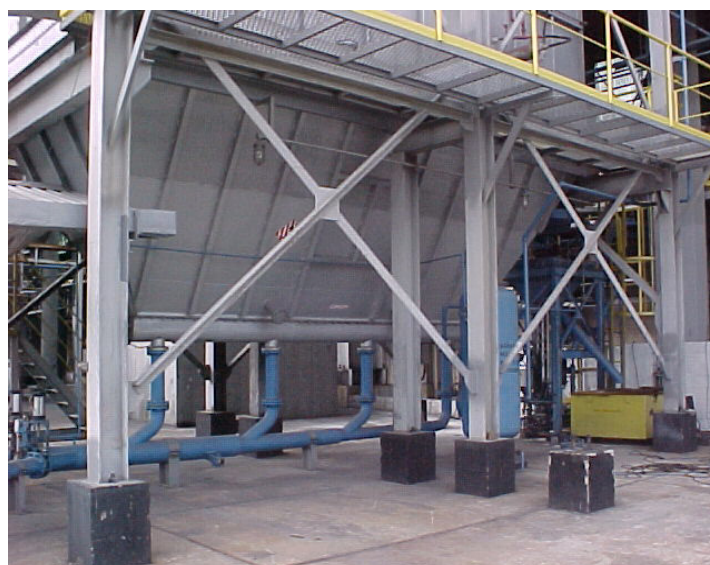
Figura 5.9 - Foto mostrando a moega do FM 212002 e dutos de insuflamento do ar de fluidização no leito fluidizado – fonte: Albras.
