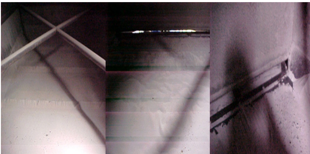
Figura 5.13 - Primeira camada de alumina formada no leito fluidizado do 212002 – fonte: Albras.
