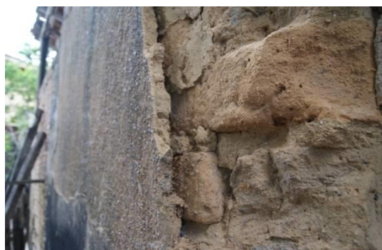
Figura 2.6: Detalhe da parede em taipa de mão, tabique. Foto: Fortunato Neto (2011).
