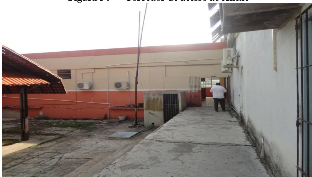
Figura 34 — Corredor de acesso ao Anexo
