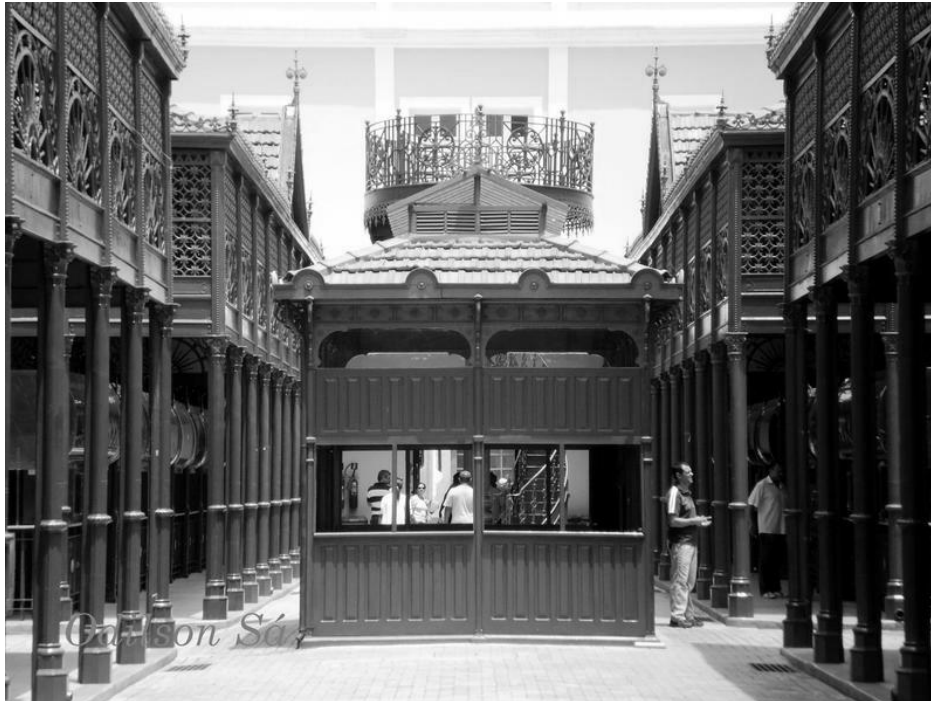
Figura 5 – Vista interna do Mercado Municipal de Belém, após a reforma e implantação do conjunto arquitetônico de Ferro realizado pelo Engº Francisco Bolonha em 1908.
