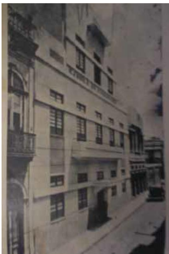
Figura 8 – Escola de Engenharia do Pará, fundada em 1931. Situada na Travessa Campos Sales, esquina com a Rua Manoel Barata. Fonte: ALMEIDA, Ruy Guilherme Castro. O papel dos engenheiros e matemáticos na história do ensino de física no Pará (1931-1970) . Tese de Doutorado. São Paulo: USP, 2006.
