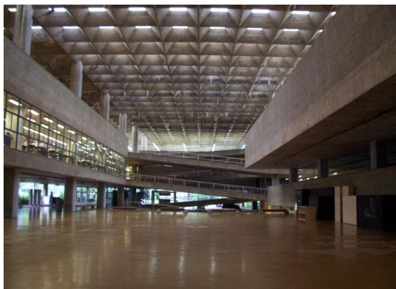
Figura 14. Grelha de vigas da cobertura da FAUUSP, Arq. João Vilanova Artigas, 1969 Fonte: http://www.vitruvius.com.br/revistas/read/arquitextos/04.044/622
