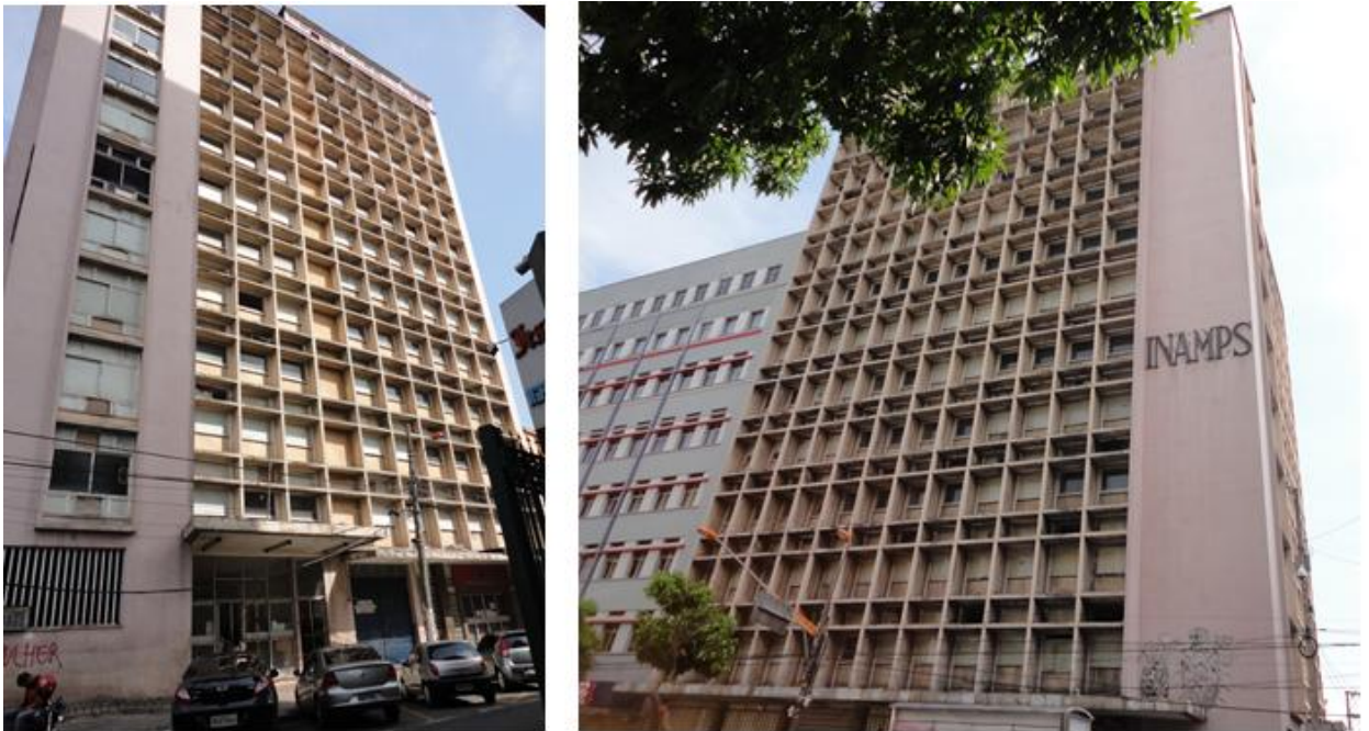
Figura 19. Foto da fachada lateral do edifício do INAMPS (esq.) e da fachada principal e sua relação com a edificação vizinha (à direita). Fonte: Autora (2012).
