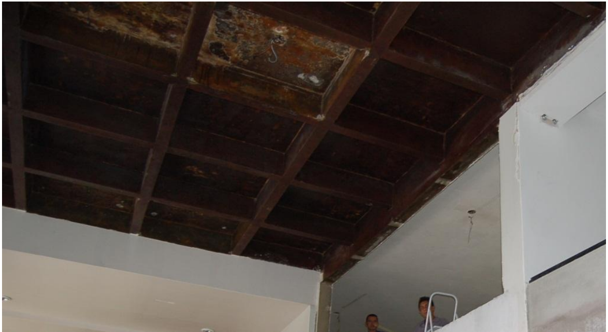
Figura 38. Vista da laje da Biblioteca Benedito Frade do TCE-PA Fonte: Acervo do Tribunal de Contas do Pará
