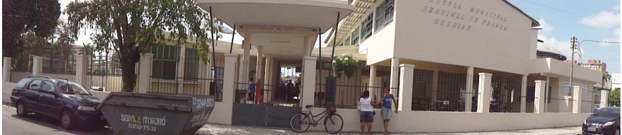
Figura 9. Fachada principal da Escola Benvinda de França Messias. Fonte: Autora (2012).
