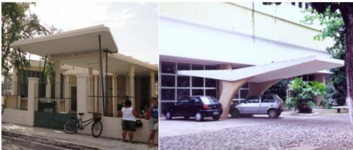
Figura 29. Laje de acesso da Escola Benvinda de França Messias (à esquerda) e da Escola dos Cataguases.
