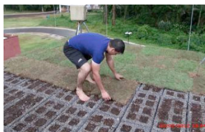
Figura 61: Aplicação do telhado vegetal.
