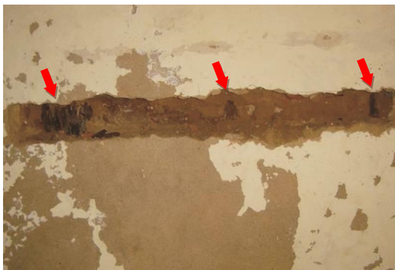
Figura 216 - Alvenarias em pedra argamassada com estrutura de madeira interna. Prospecções realizadas nas alvenarias do prédio do Solar do Barão de Guajará, durante a última intervenção. Fonte: Acervo particular de Sales Engenharia, 2007.
