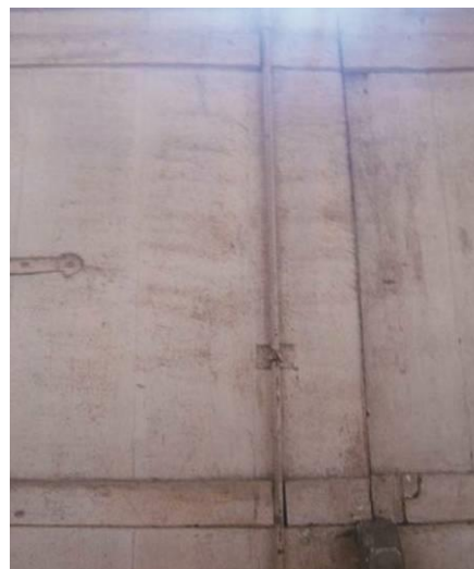
Figuras 217 e 218 - Ferragens utilizadas nas portas e janelas do Solar do Barão de Guajará. Esquerda: Dobradiça do tipo leme de cachimbo. Direita: Ferrolho com barras verticais articuladas por meio de rotação. Fonte: Acervo particular de Sales Engenharia, 2007.
