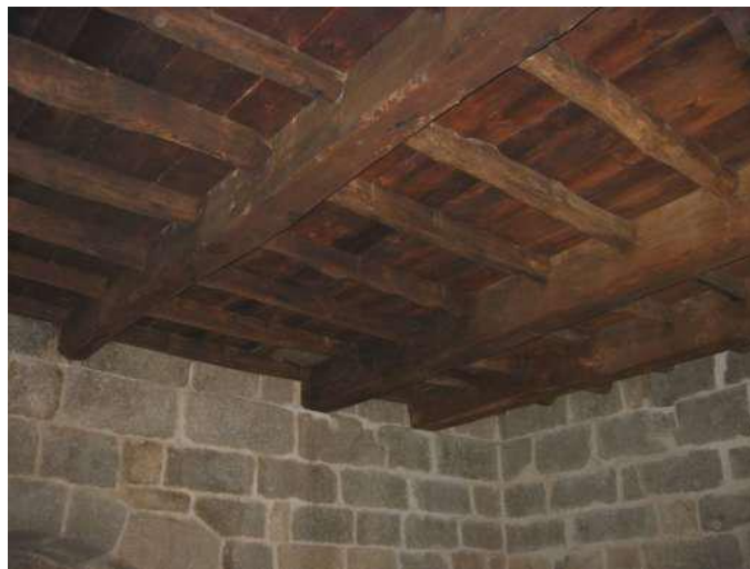
Figura 26 - Foto com estrutura de madeira do piso sobrado aparente, fazendo as vezes de teto do andar térreo. Fonte: LOPES, 2007.
