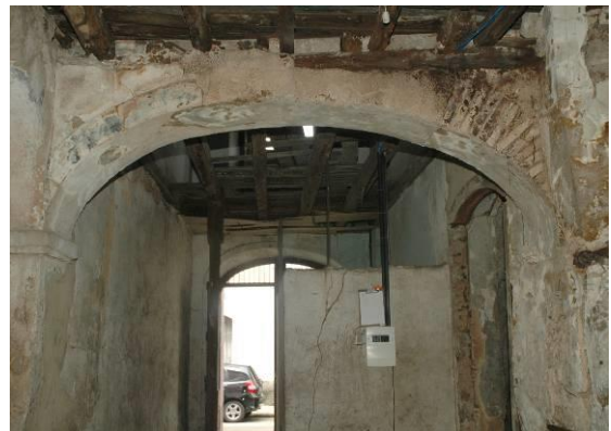
Figuras 222 e 223 - Estruturação dos arcos dos vãos em tijolo cerâmico, na Casa Rosada. Fonte: RAMOS, 2010; RAMOS, 2007.
