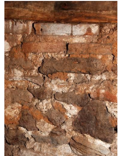
Figuras 219 e 220 - Sistema de alvenaria similar ao tipo “gaiola”, na Casa Rosada, em estrutura de madeira com fechamento em pedras da região, argamassadas, e embrechadas com tijolos cerâmicos. Fotos: Geraldo Ramos. Fonte: RAMOS, 2009.
