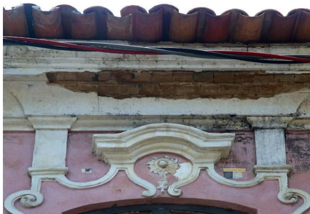
Figura 148 - Estuques utilizando tijolos cerâmicos na conformação dos detalhes da fachada da Casa Rosada. Fonte: RAMOS, 2010.
