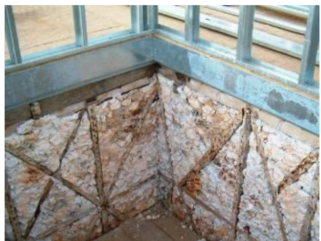
Figuras 21 e 22 - Sistema construtivo de alvenaria mista com estrutura de madeira (gaiola) e fechamento em pedra. Fonte: http://cidadania1x.blogspot.com.br ; http://commons.wikimedia.org .
