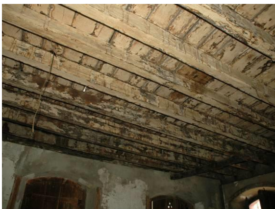
Figuras 228 e 229 - Tipos de teto da Casa Rosada. Teto em madeira do andar térreo com barroteamento e assoalho aparente. Teto em madeira do andar superior com vestígio de guarda-pó. Fonte: RAMOS, 2007; RAMOS, 2009.
