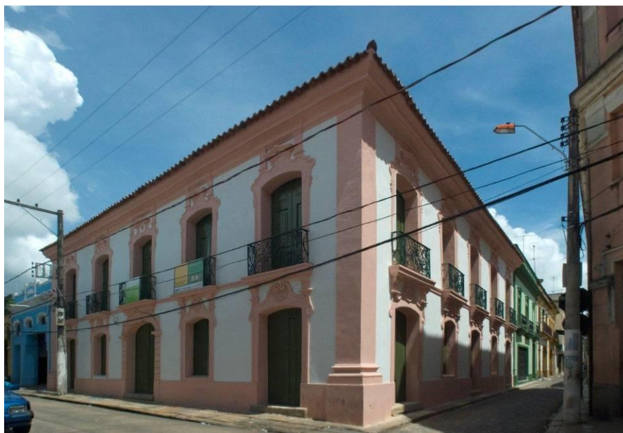
Figura 134 - Foto da Fachada da Casa Rosada após o restauro, na esquina da Rua Siqueira Mendes com a Travessa Félix Rocque. Fonte: RAMOS, 2010.
