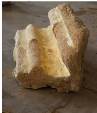
Figuras 230 e 231 - Tipos de teto da Casa Rosada. Vestígios de cornijas e forro em estuque no teto da área da escada, no andar superior. Fonte: RAMOS, 2010.
