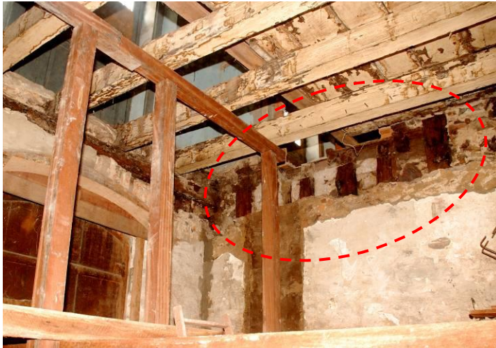
Figuras 219 e 220 - Sistema de alvenaria similar ao tipo “gaiola”, na Casa Rosada, em estrutura de madeira com fechamento em pedras da região, argamassadas, e embrechadas com tijolos cerâmicos. Fotos: Geraldo Ramos. Fonte: RAMOS, 2009.
