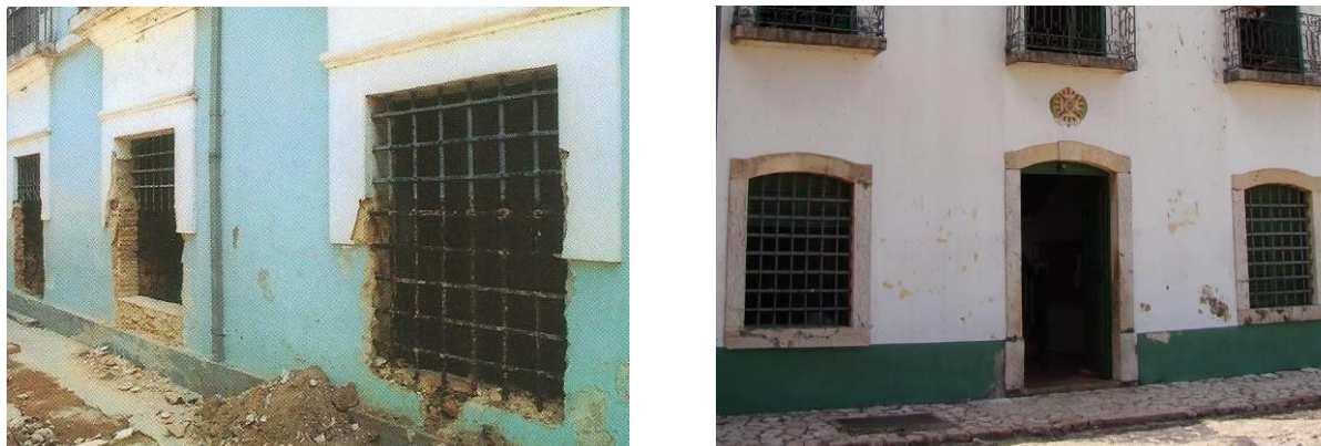
Figuras 237 e 238: Tipo de grade de ferro de fechamento de vão. Esquerda: Grade no andar térreo da Casa das Onze Janelas. Direita: Grade no andar térreo da Casa de Câmara e Cadeia de Alcântara, Maranhão.
