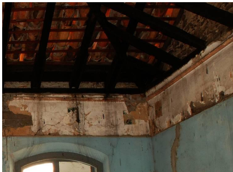
Figura 232 - Tipos de teto da Casa Rosada. Vestígios de cornijas em estuque no teto da Sala de Visitas no andar superior. Fonte: RAMOS, 2009.
