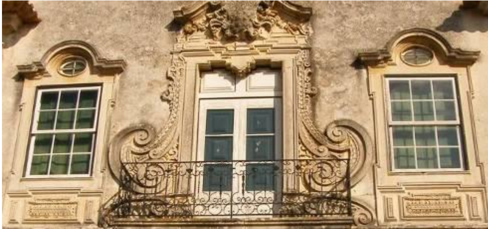
Figura 36 - Foto de fachada com esquadria de vidro na parte externa e esquadria de madeira com almofada na parte interna, pavimento nobre, Palácio Lemos Ramalho, Coimbra, Portugal.
