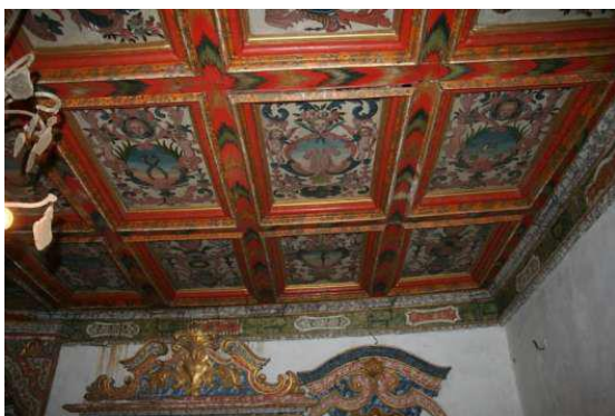
Figuras 31 e 32 - Tipos de tetos em madeira. Esquerda: Teto de caixotão. Direita: Detalhes em cortes esquemáticos de forro de caixotão independente (acima) e utilizando o assoalho do piso superior.
