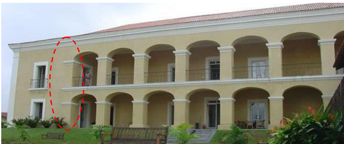
Figura 192 - Fachada posterior da Casa das Onze Janelas, antigo Hospital Real Militar de Belém do Pará, projetado por Antonio José Landi. Fonte: http://ufpa.br
