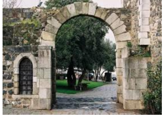
Figuras 19 e 20 - Fotos de estrutura de vãos em alvenarias de pedras, Portugal. Esquerda: verga de arco curvo com tijolo cerâmico. Direita: arco e vão de janela estruturados em pedra aparelhada. Fonte: http://arrumario.blogspot.com.br ; http://mjfs.wordpress.com
