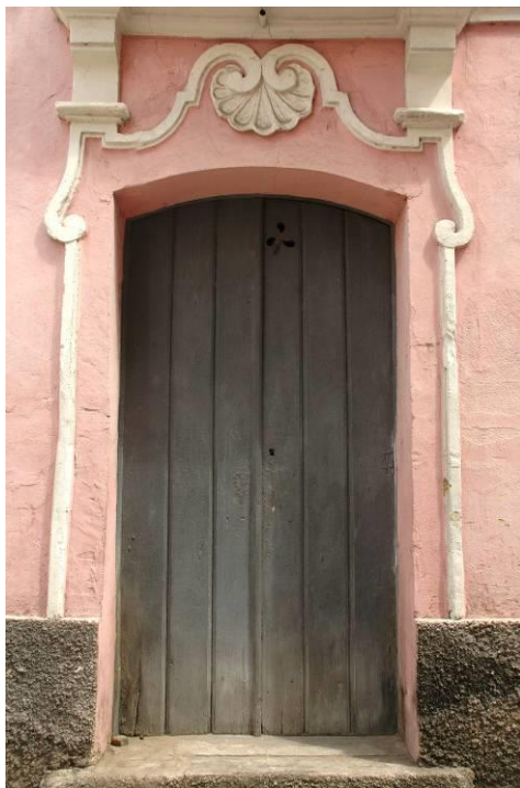
Figuras 233 e 234 - Tipos de portas da Casa Rosada. Esquerda: Porta em madeira, com tábuas no sentido vertical, do andar térreo. Direita: Porta em madeira, com almofadas e postigo, do andar superior.
