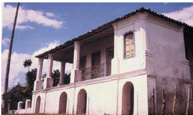
Figura 54 - Varandas na fachada. Foto da Casa-Grande do Engenho Tarefas, em Teodoro Sampaio, na Bahia, Brasil. Fonte: AZEVEDO, 2009.
