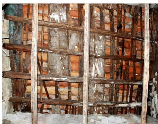
Figuras 228 e 229 - Tipos de teto da Casa Rosada. Teto em madeira do andar térreo com barroteamento e assoalho aparente. Teto em madeira do andar superior com vestígio de guarda-pó. Fonte: RAMOS, 2007; RAMOS, 2009.
