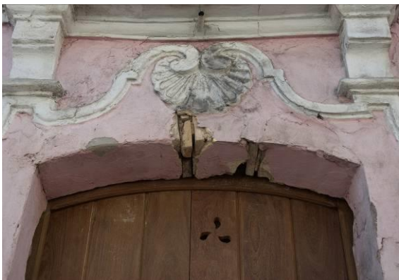
Figuras 222 e 223 - Estruturação dos arcos dos vãos em tijolo cerâmico, na Casa Rosada. Fonte: RAMOS, 2010; RAMOS, 2007.
