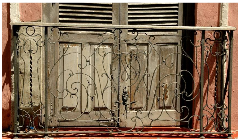
Figura 149 - Tipo de balcão das sacadas da Casa Rosada. Feito em ferro forjado, de influência Rococó. Fonte: RAMOS, 2007.
