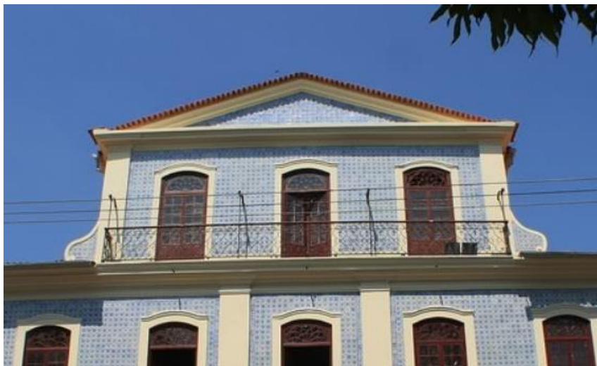
Figura 131 - Terceiro pavimento, com camarinha ou mirante na fachada do Solar do Barão de Guajará, em frente à Praça Dom Pedro II, antigo Largo do Palácio. Fonte: SÁ, 2011
