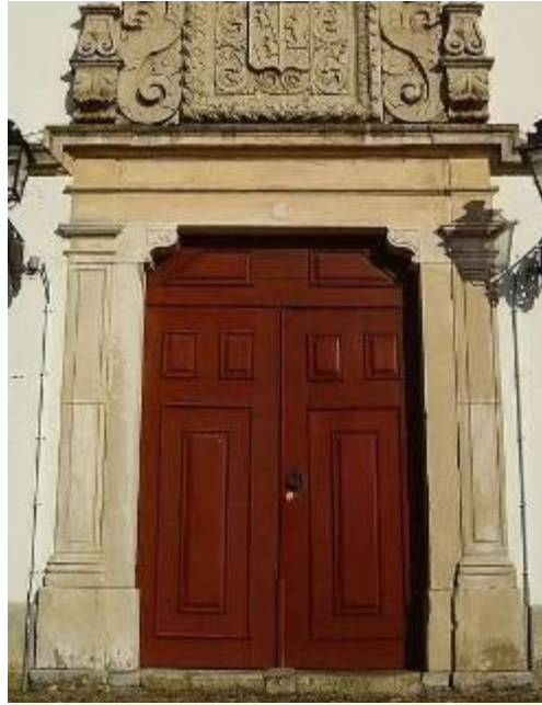
Figura 37 - Foto de porta de duas folhas com almofadas em madeira, Palácio dos Figueiredos Coimbra, Portugal. Fonte: http://www.skyscrapercity.com
