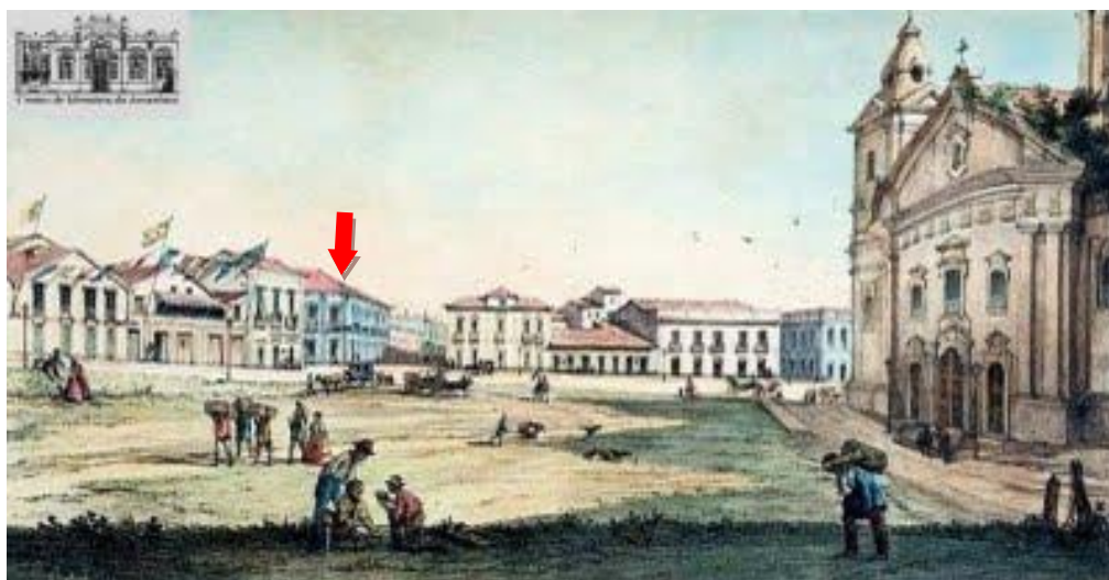
Figura 113 - Largo das Mercês e as edificações ao seu entorno, com destaque para o prédio azul da esquina à esquerda, no segundo plano, antiga residência de Manuel Alves da Cunha, indicado pela seta em vermelho, retratado em litogravura. Fonte: RIGHINI, 1867.
