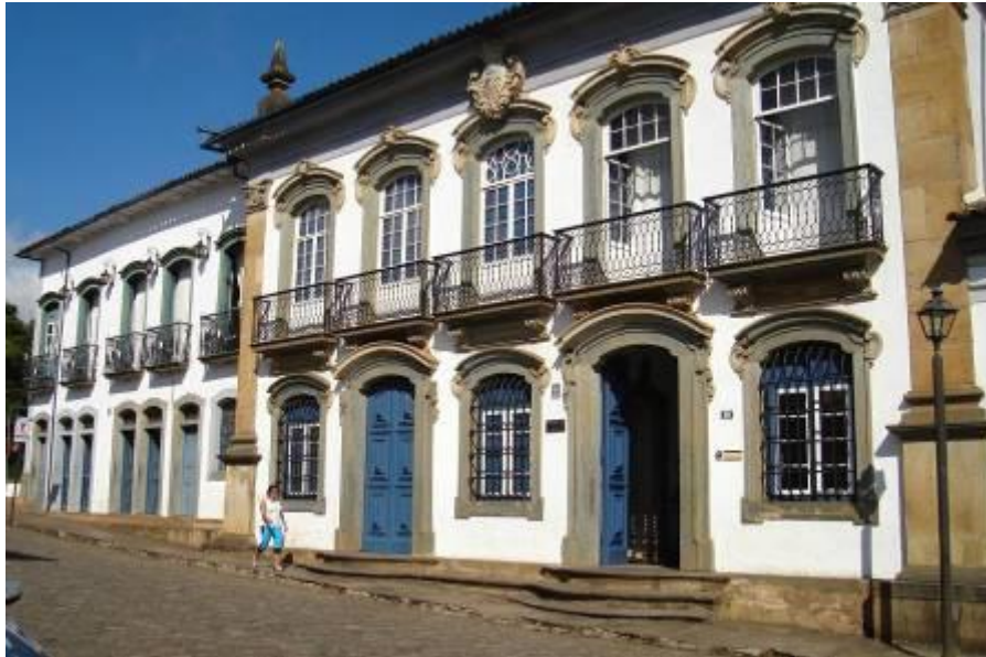
Figura 56: Edificação destacada pela cantaria nos elementos estruturantes e decorativos da fachada, como brasão. Foto da antiga Casa Capitular de Mariana, Minas Gerais, Brasil.
