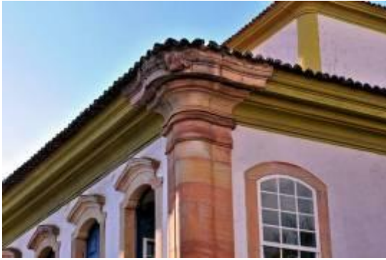
Figuras 77 e 78 - Detalhes construtivos e decorativos da Casa dos Contos em Ouro Preto, em Minas Gerais, Brasil. Esquerda: cornija e cunhal. Direita: sacada com balcão. Fonte: http://interata.squarespace.com
