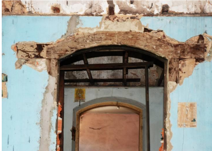
Figura 221 - Estruturação dos vãos internos da Casa Rosada, com o conjunto de vergas e ombreiras em madeira, atrelado à estrutura de esteios embutidos na alvenaria de pedra. Fonte: RAMOS, 2009.
