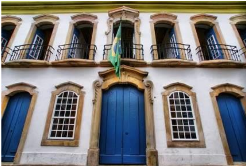
Figura 65 - Foto da Morfologia de fachada da Casa dos Contos de Ouro Preto, em Minas Gerais, Brasil.
