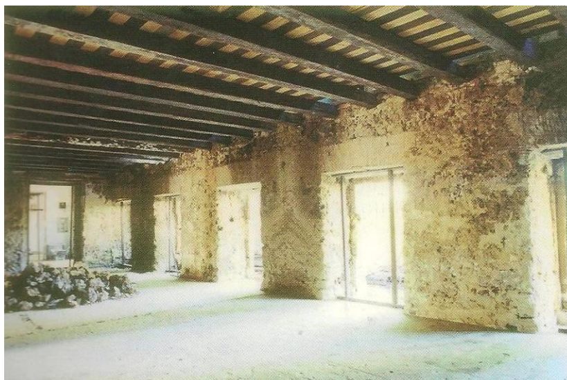
Figura 236 - Tipo de teto do andar térreo da Casa das Onze Janelas. Teto em madeira com assoalho e barroamento aparente. Fonte: PARÁ, 2006.
