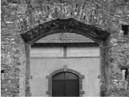
Figuras 19 e 20 - Fotos de estrutura de vãos em alvenarias de pedras, Portugal. Esquerda: verga de arco curvo com tijolo cerâmico. Direita: arco e vão de janela estruturados em pedra aparelhada. Fonte: http://arrumario.blogspot.com.br ; http://mjfs.wordpress.com
