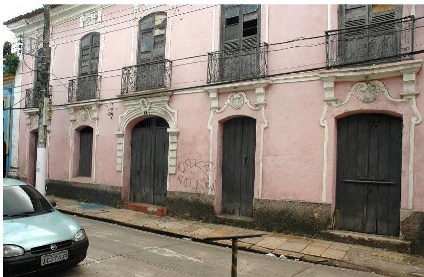
Figura 137 - Foto da Fachada adulterada, antes da restauração da Casa Rosada. Fonte: RAMOS, 2007.
