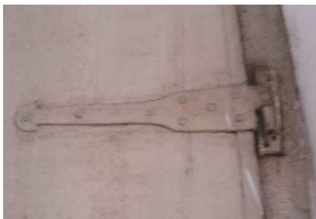
Figuras 217 e 218 - Ferragens utilizadas nas portas e janelas do Solar do Barão de Guajará. Esquerda: Dobradiça do tipo leme de cachimbo. Direita: Ferrolho com barras verticais articuladas por meio de rotação. Fonte: Acervo particular de Sales Engenharia, 2007.
