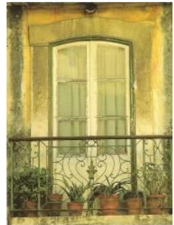
Figuras 40, 41 e 42 - Fotos de tipos de balcão. Esquerda: em madeira torneada. Centro: em ferro forjado, com varões, nódulos e barra. Direita: em ferro com desenhos de influência rococó. Fonte: MATOS, 1994.
