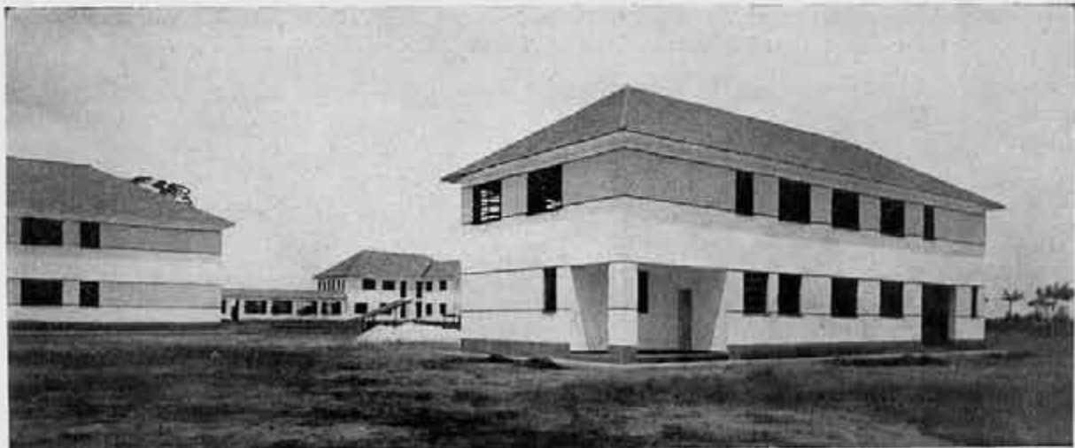
Pavilhão da Crèche (Nursery).
