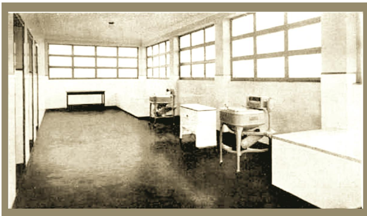
IMAGEM 30: Vista interna da lavanderia
