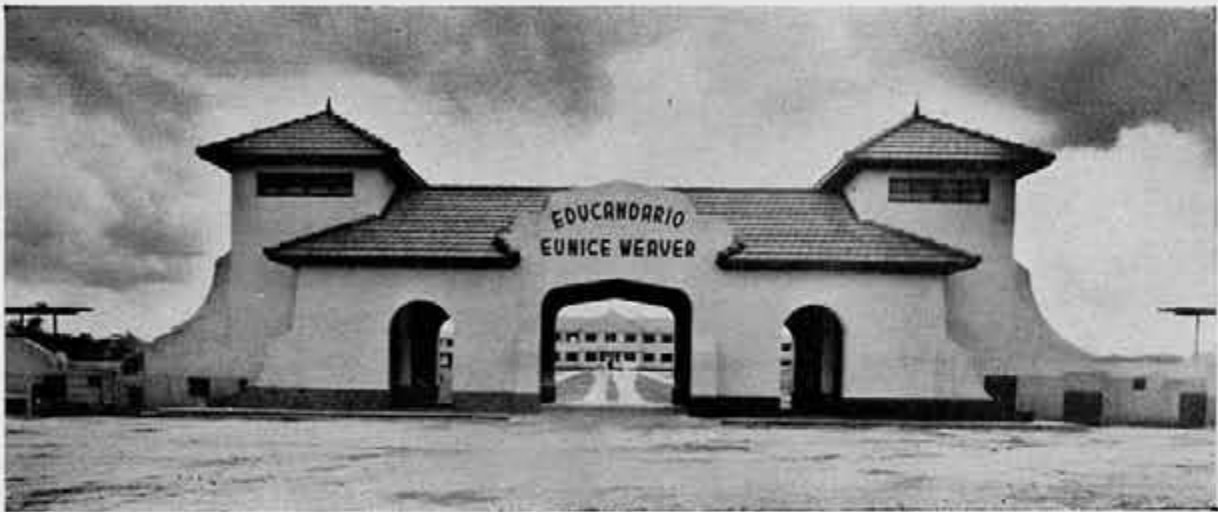
Portaria da Entrada Principal. Este preventório foi inaugurado em 12-2-1942 e em Março de 1942 ocupado pelo Ministério da Guerra, para quartel, durante a guerra.
