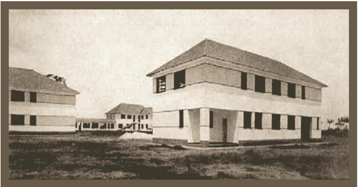
IMAGEM 19: O pavilhão da Creche
