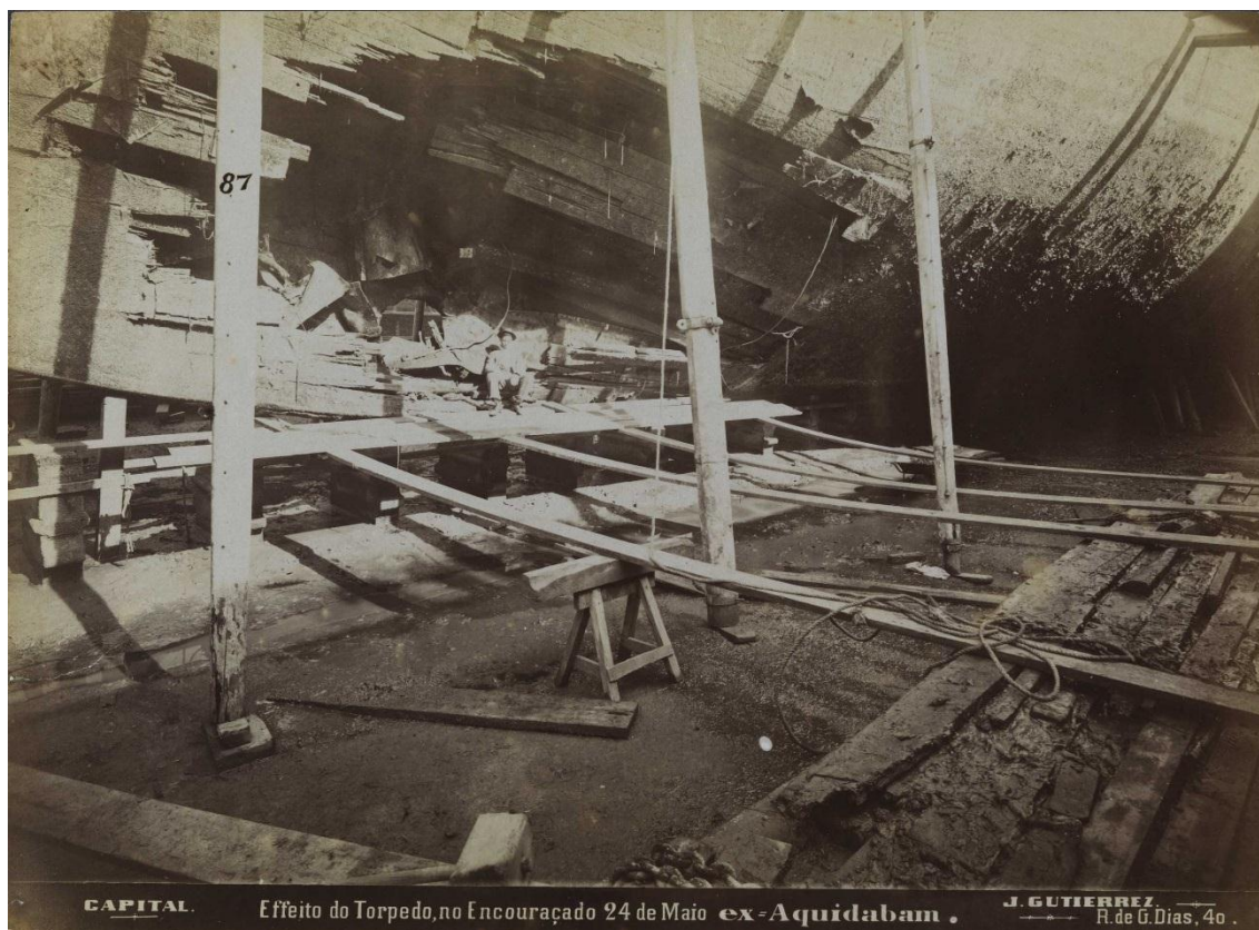
Figura 43 - Outro ângulo do buraco causado pelo torpedo. Observe a pessoa sentada próximo ao local, o que sugere a dimensão da explosão. 265
