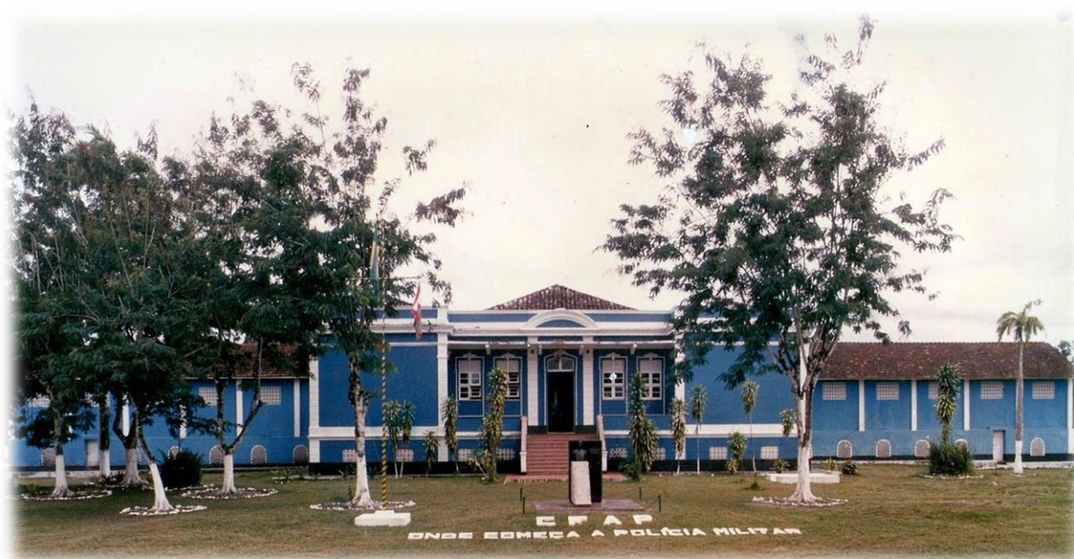
Figura 20 - Fachada do CFAP (1986)
