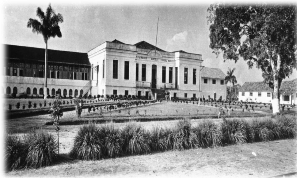
Figura 18 - Fachada do Patronato Agrícola Manoel Barata
