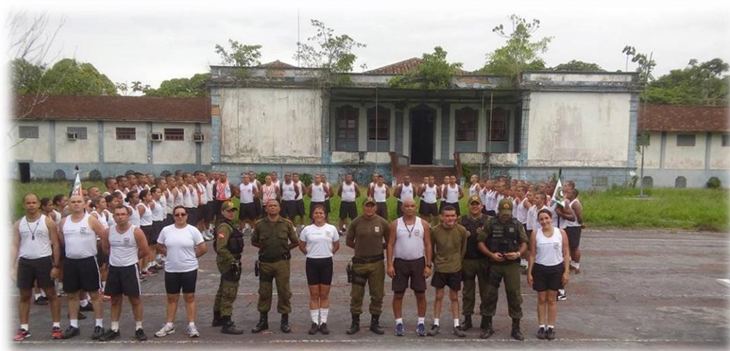
Figura 21 - Fachada do prédio do antigo CFAP na atualidade
