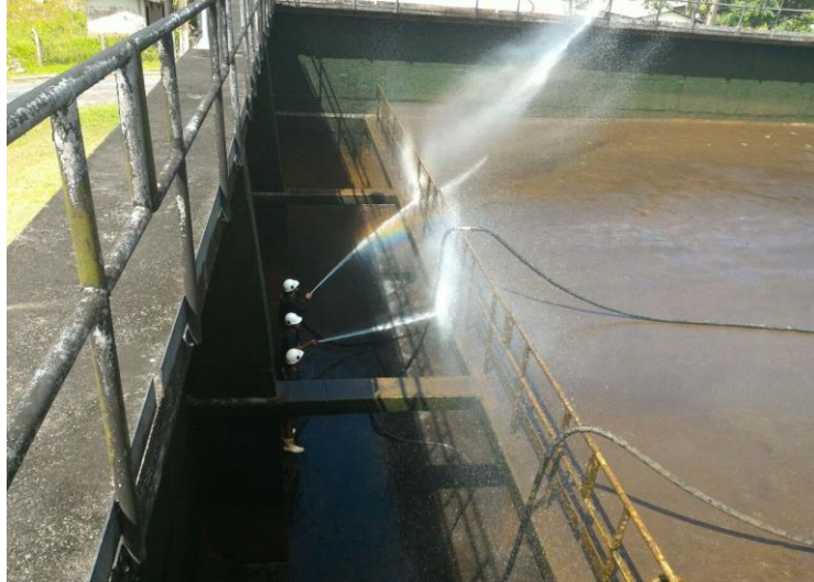
Figura 3.3: Limpeza do lodo de um dos decantadores da ETA Bolonha.
