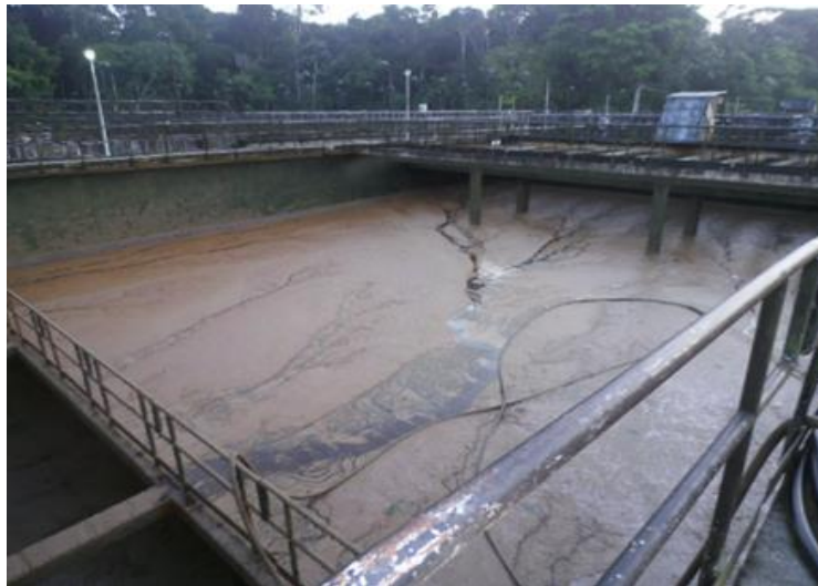
Figura 3.4: Decantador da ETA Bolonha esvaziado para início dos trabalhos de coleta.
