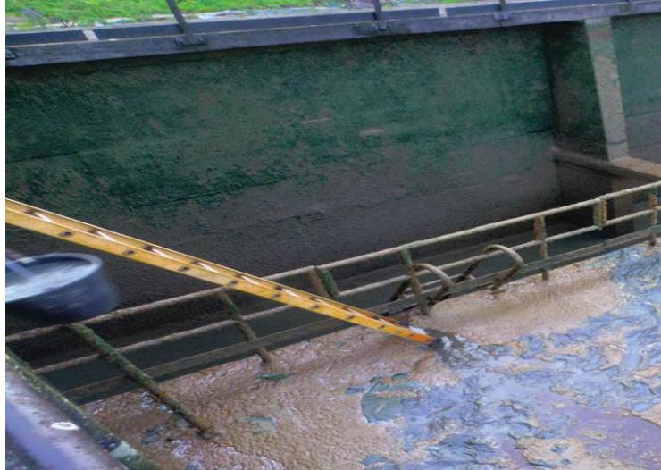
Figura 3.6: Coleta do lodo no fundo do decantador com auxílio de escada e um recipiente de 12 litros içado com corda.
