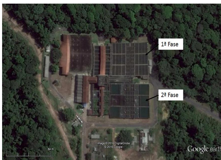
Figura 3.2: Vista área dos decantadores
