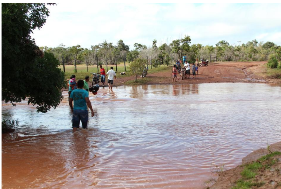
Figura 22 - Trecho da rodovia MA-01 cortada pelo igarapé do Ererê, local chamado de Urubu, 16 Mai. 2013
