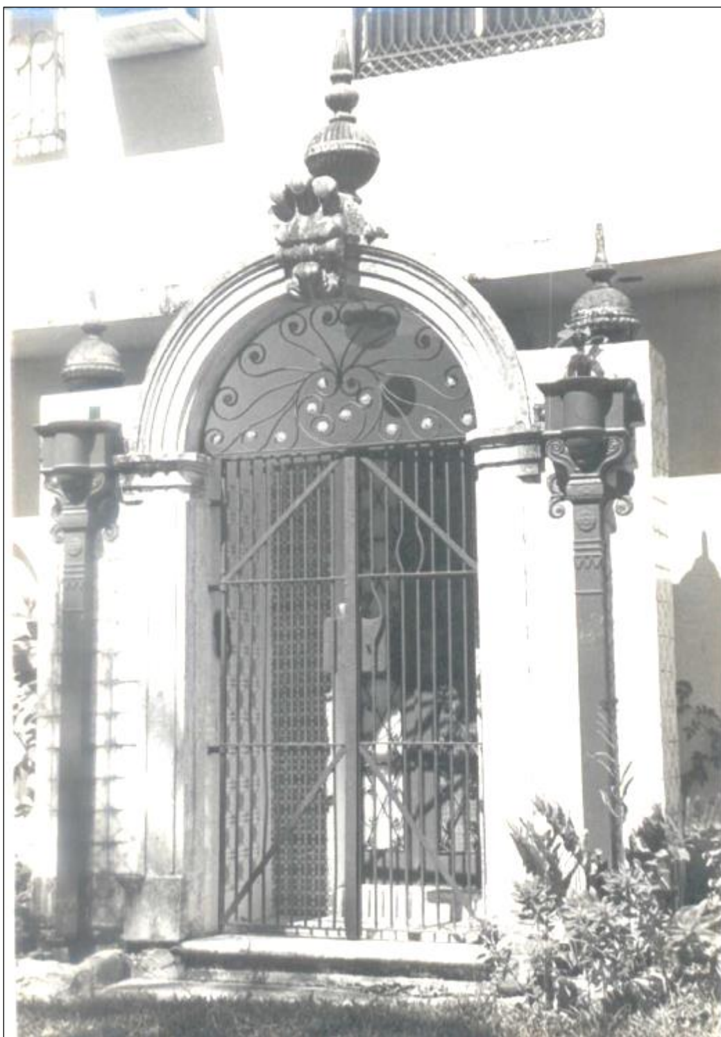
Figura 41: Pórtico de entrada da casa de Kenichiro Motoki feito com os elementos arquitetônico de um dos prédios que ele demoliu. (Fonte: Arquivo Institucional SIM/SECULT)
