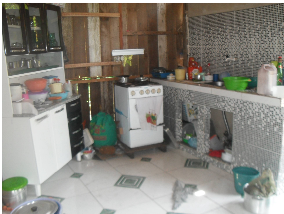
Figura 1: Casa de um morador quilombola mostrando a melhoria das instalações de sua cozinha. Notar as lajotas no chão. Enquanto as paredes ainda são de madeira para melhorar a ventilação.
