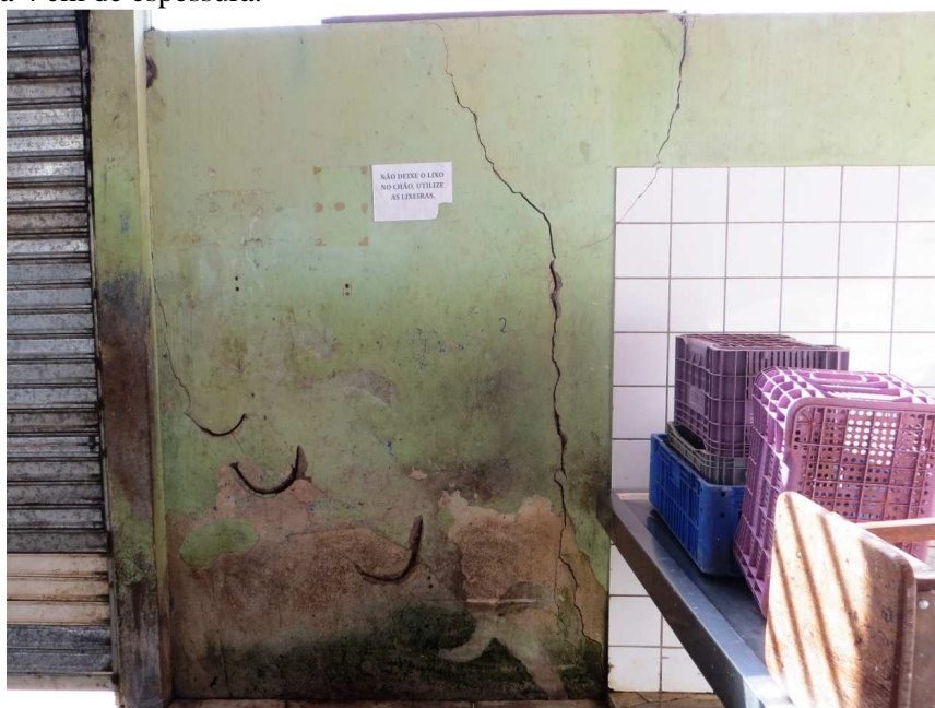
Figura 16: Nas paredes, as trincas alcançam 2 m de altura e 1 cm de espessura, aproximadamente.
