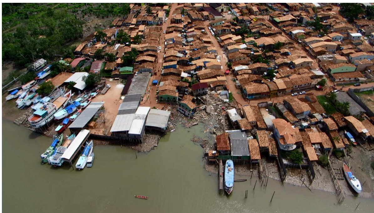
Figura 3: Colapso do aterro resultou em 13 casas destruídas e 49 interditadas.
