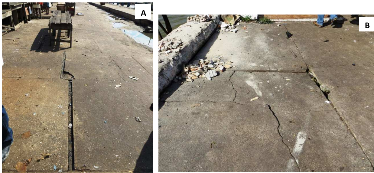
Figura 18: (A) Deslocamento e recalque dos blocos que compõem o chão da feira. (B) Trincas que se formam durante o recalque do solo.
