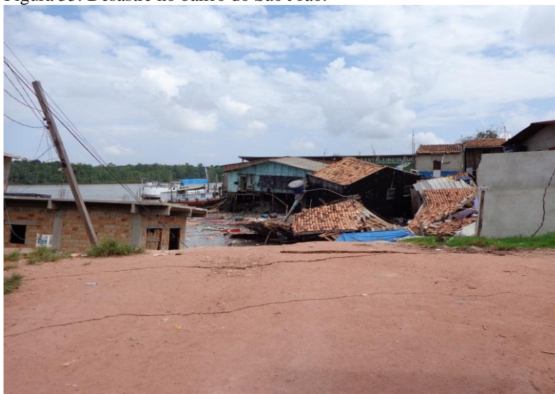
Figura 33: Desastre no bairro do São João.
