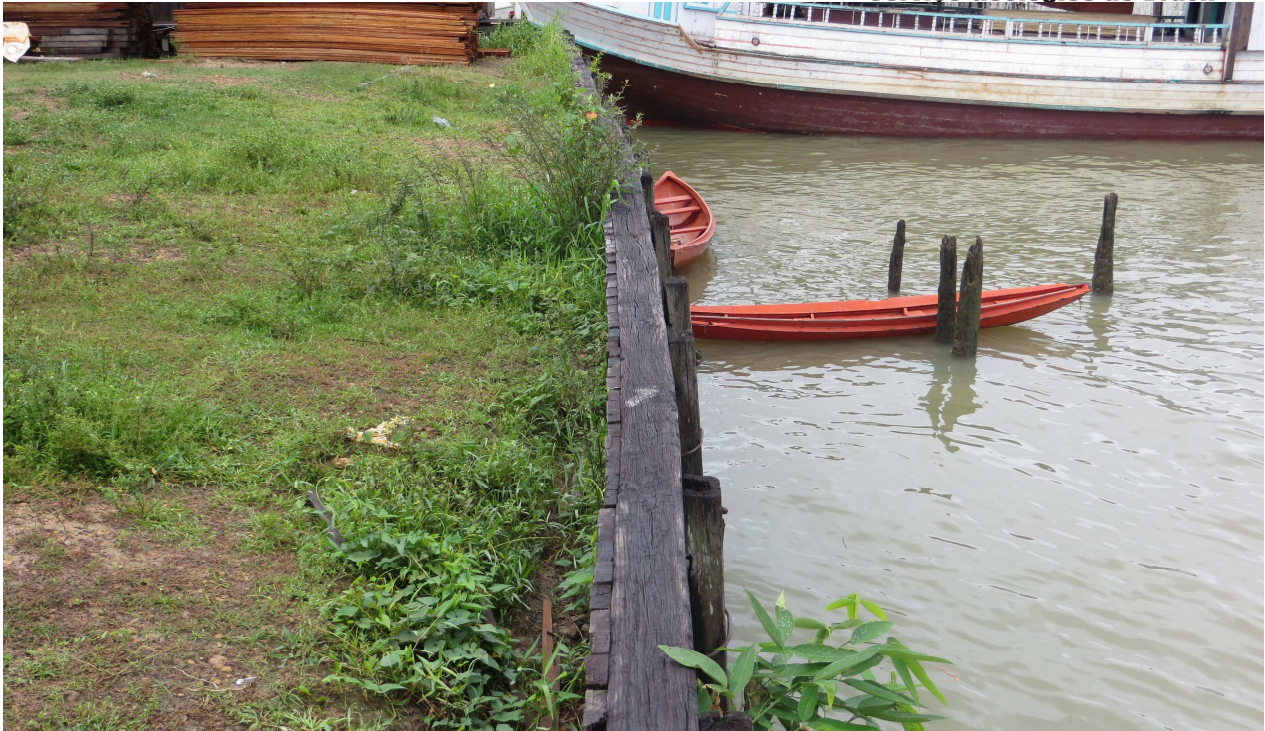
Figura 14: Talude contido por um muro de contenção de madeira.
