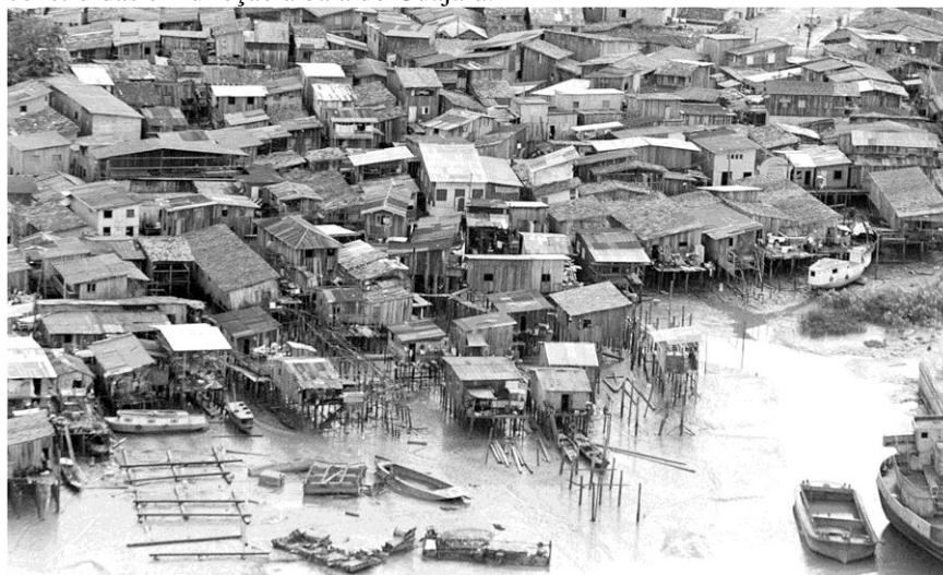
Figura 74: Conjunto Vila da Barca Belém/PA na década de 1970, estilo palafitas das residências construídas em direção à baía do Guajará.
