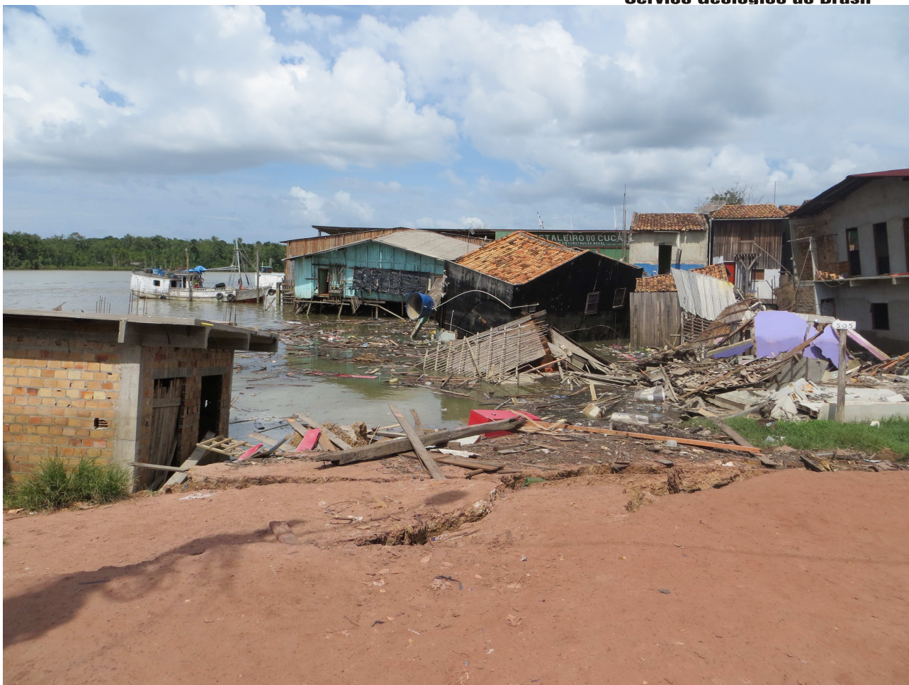
Figura 4: Trincas e rachaduras no aterro indicam que novos colapsos podem ocorrer.
