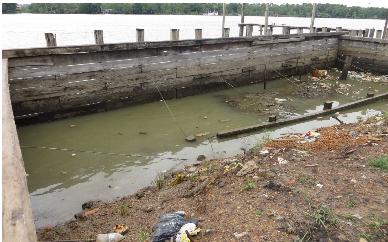
Figura 11: Exemplo típico de construção de um talude artificial ao longo da orla de Abaetetuba.
