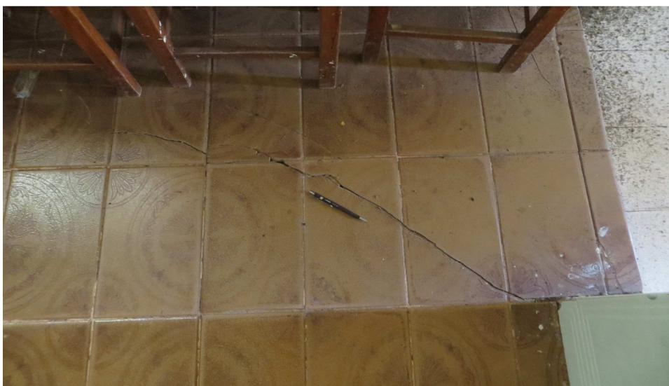
Figura 12: Trincas no piso da Igreja, ocasionadas por recalque.
