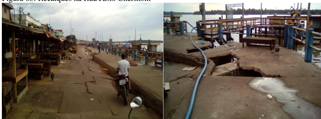
Figura 63: Recalques na Rua Justo Chermont
