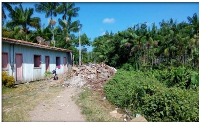
Figura 30: Aterramento da planície de inundação em 2015
