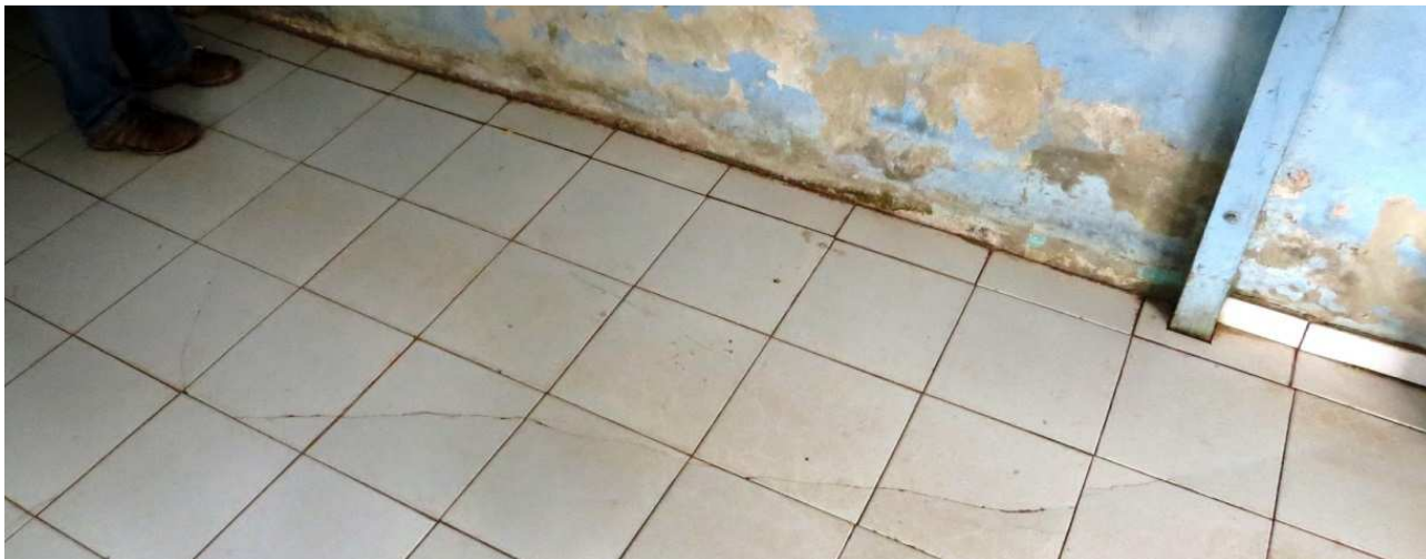
Figura 5: Ocorrência de trinca no piso da residência.
