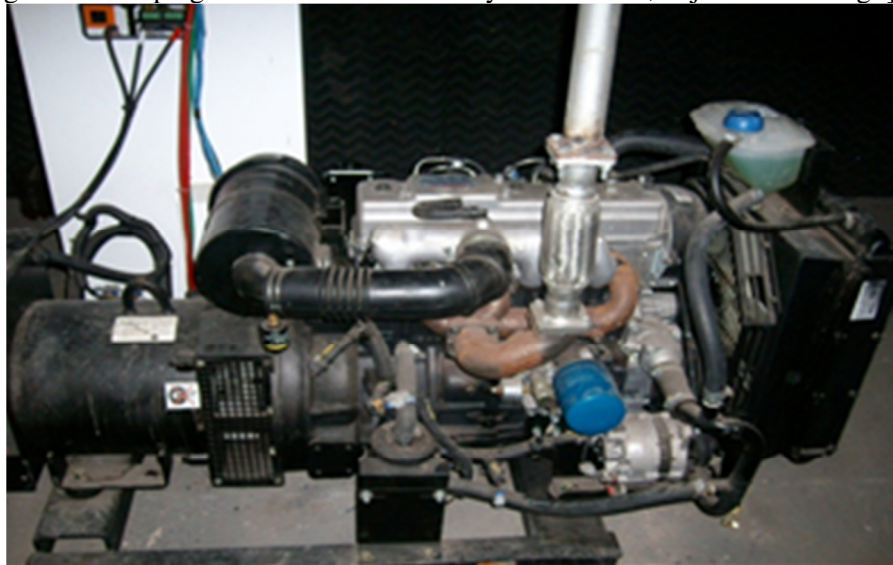
Figura 7 – Grupo gerador Diesel modelo Hyundai D4BB, objeto da investigação.
